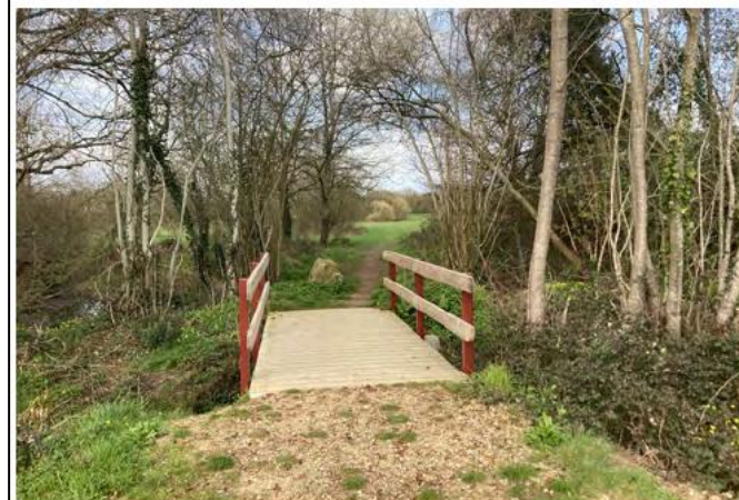
8. Franchissement du ruisseau en fond de vallon.
