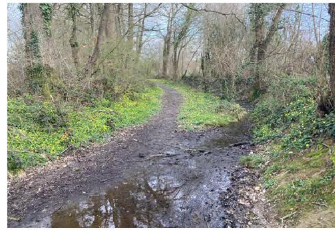
1. Chemin de la Hubaudière inondé.
