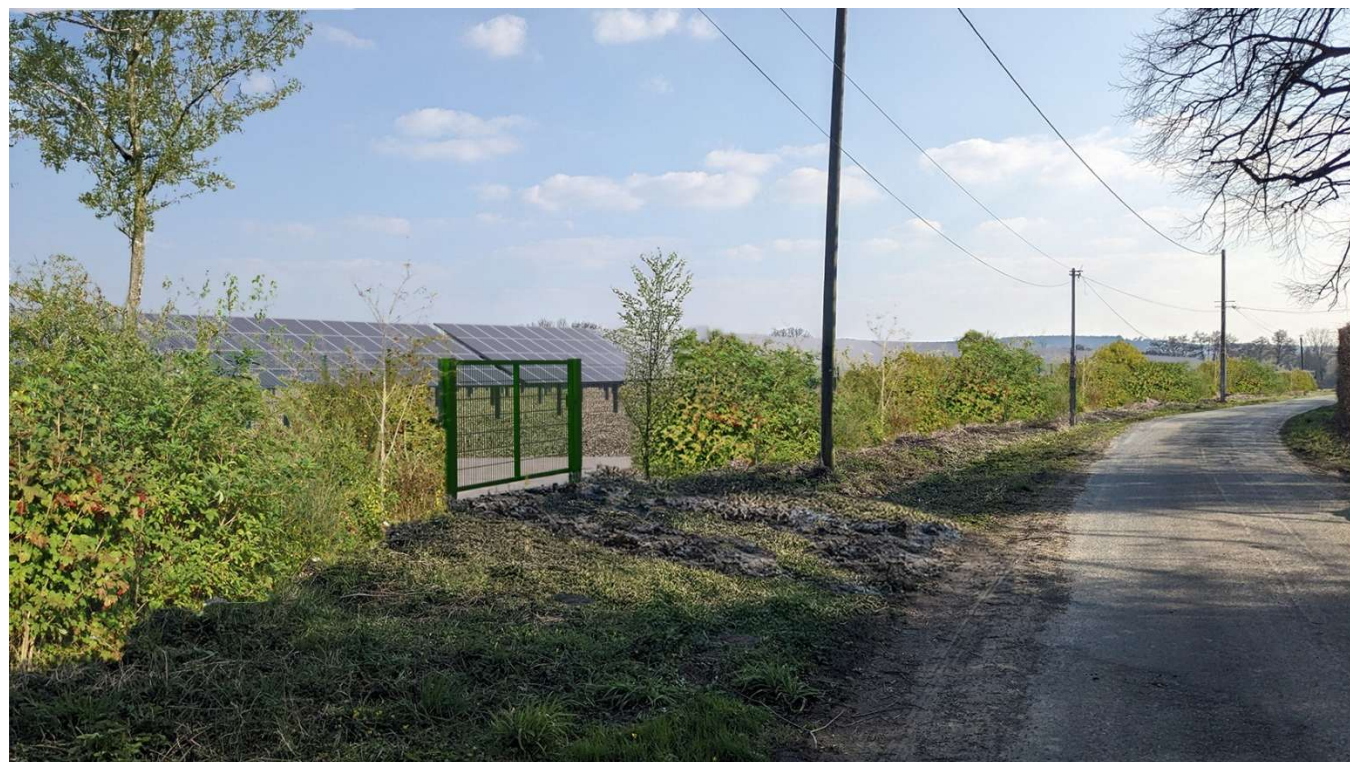
Photo 1 : Vue I avec mesures ERCA, depuis la route des Cornillières
