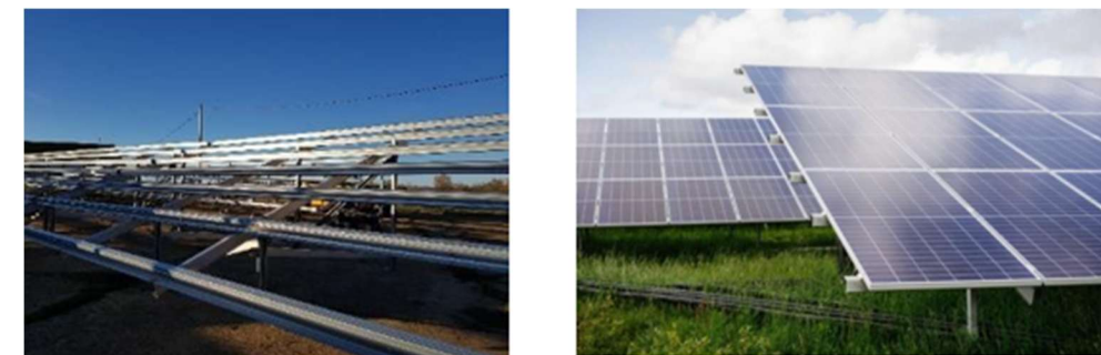
Figure 4 Illustrations de table fixe sans modules (gauche) et table fixe 3VH (3 modules verticaux)(droite)
