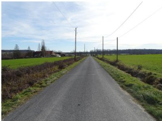
6- Route départementale D102 séparant la partie sud de la partie nord de la ZIP
