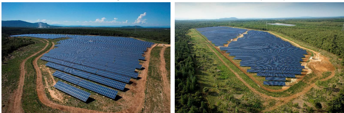
Figure 7 : Centrale solaire de Belvesol dans le Gard (20MWc)
