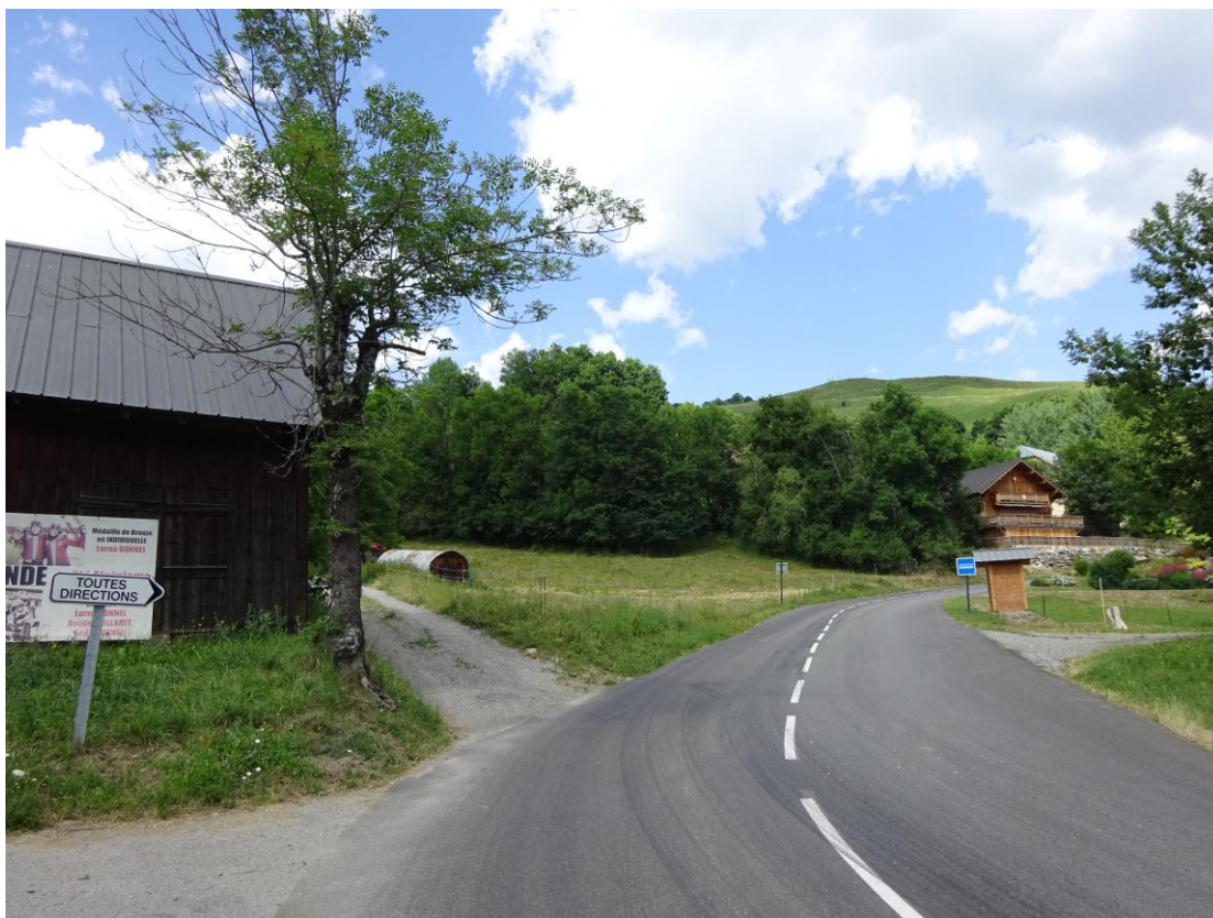
9 : Vue sur les terrains du projet depuis l'aval sur la RD 78, au droit du carrefour avec la route de la Chapelle et le chemin rural (à gauche)
