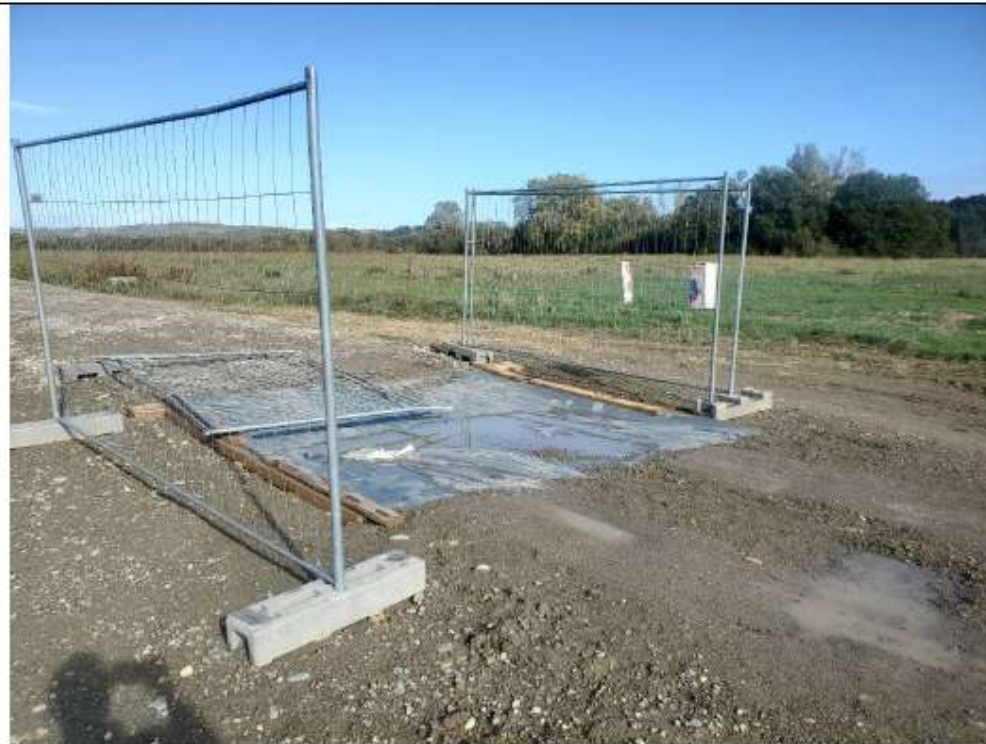
Figure 9 Photographie d'une station de lavage d'engins de chantier en entrée et sortie de site (source : GEREAA)
