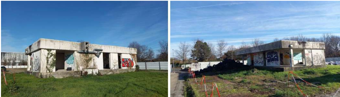
Figure 117 : Visuels du bâtiment existant à démolir (Source : BLP et HOB0 Architectes 2026)
