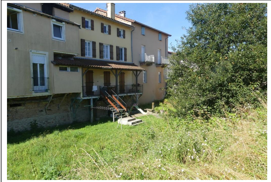
La base des constructions anciennes implantées le long de la rue de la Levée avec le niveau originel des terrains inondables par les crues de la Saône
