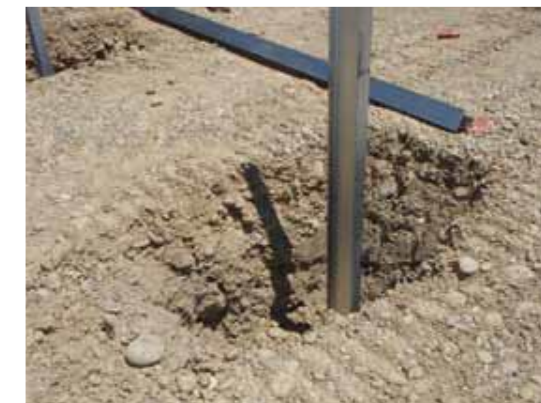
Photo 9 : Exemple de pieux en acier (Source : Guide de l'étude d'impact 2011)
