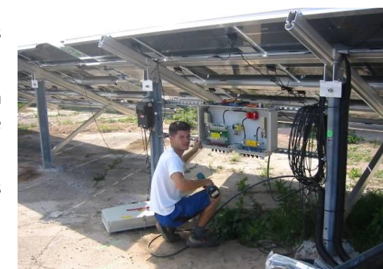
Raccordement de câbles solaires en coffret électrique
