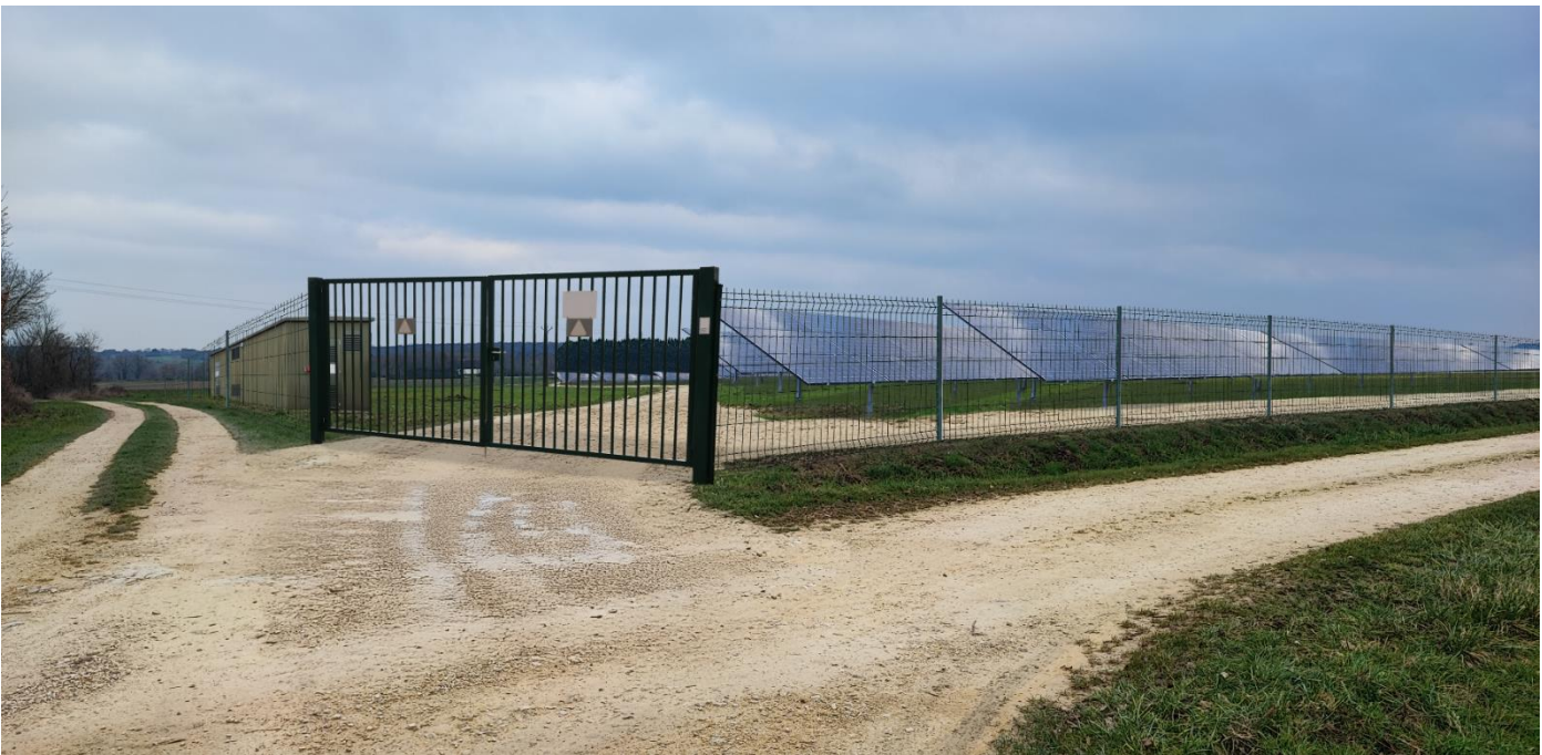
Figure 18 : Prise de vue n°1 après implantation du projet
