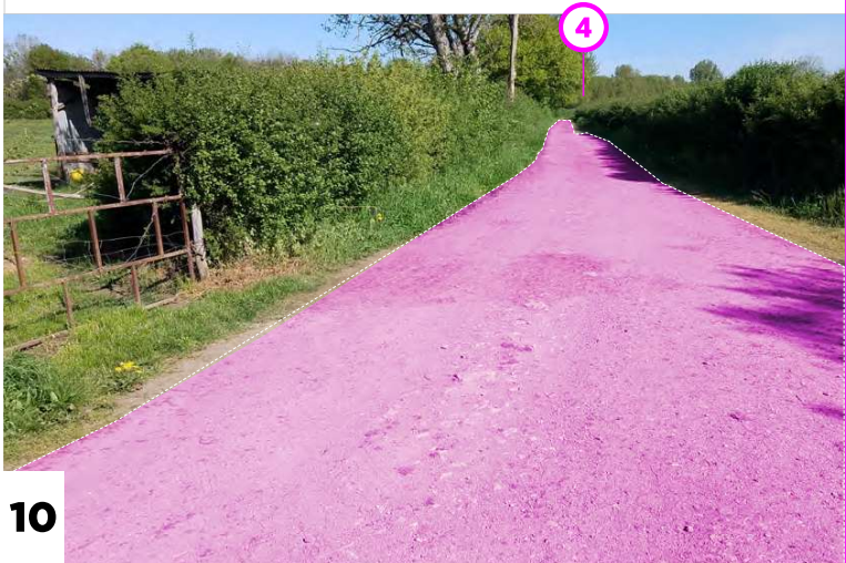
Création de la voie verte sur chemin existant
