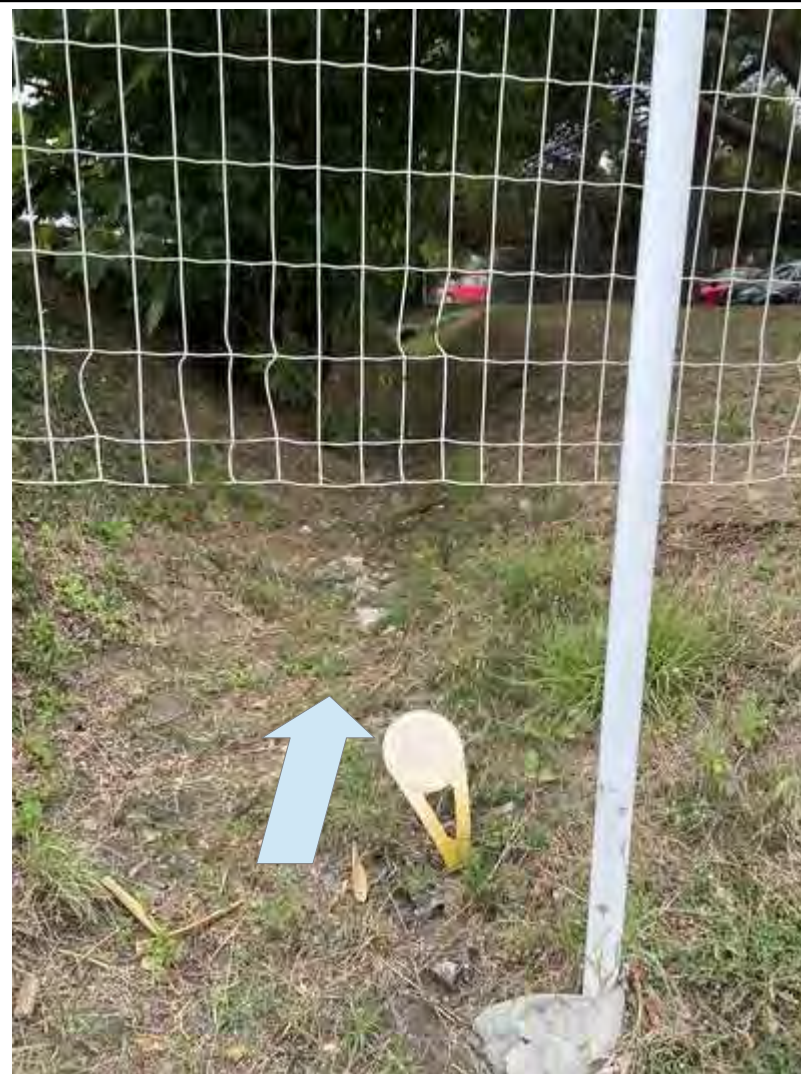
Photo N° 7 Vue du fossé exutoire (exutoire 2)
