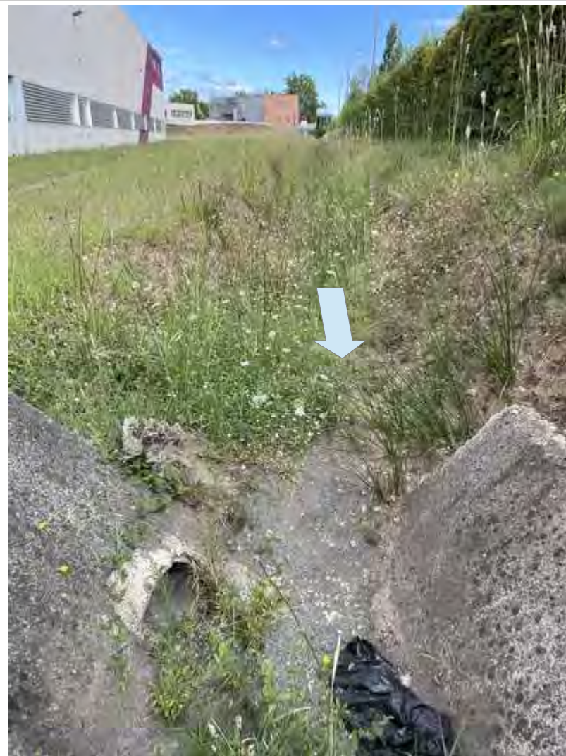
Photo N° 3 Vue du fossé collutoire – Partie Nord
