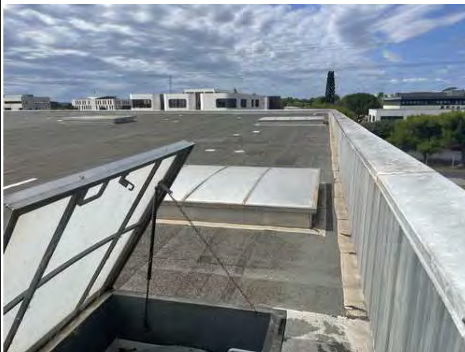
Photo N° 9 Vue du toit
