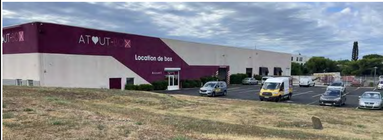
Vue de la parcelle préemptée pour l'opération
