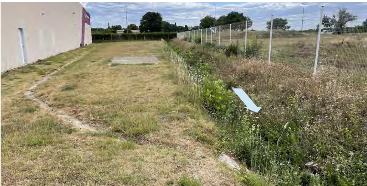
Fossé collutoire et caniveau Sud (type CC2)
