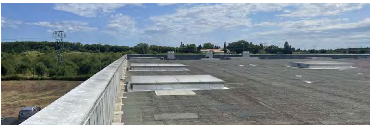
Vue de la toiture actuelle
