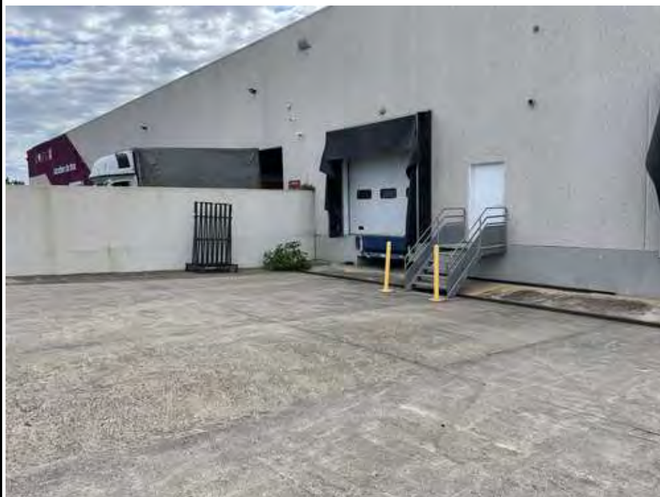
Photo N° 8 Vue du quai de chargement
