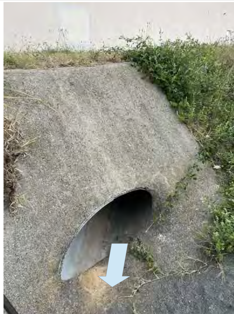
Photo N° 5 Vue de l'arrivée du réseau de toiture dans le fossé – Partie Sud
