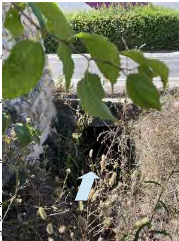
Vue de l'engouffrement du fossé dans le DN 1000 mm
