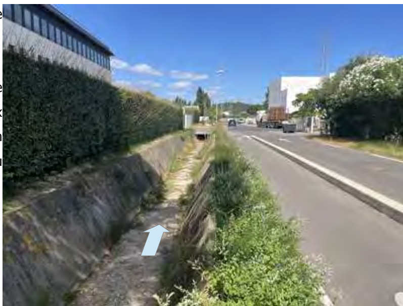
Vue de la branche Sud → Nord de la rue Clément Ader
