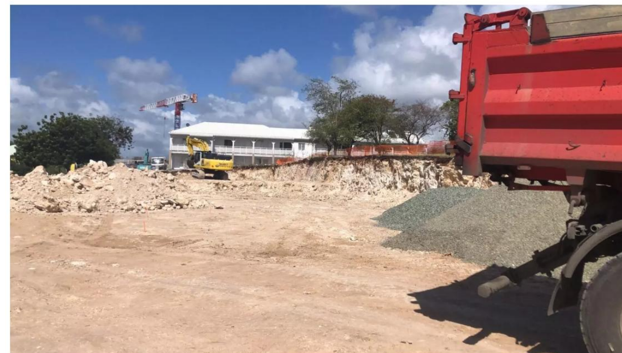
Figure 4 : Terrassement pour la création de la résidence « Diamant » (source : APROMEOS)
