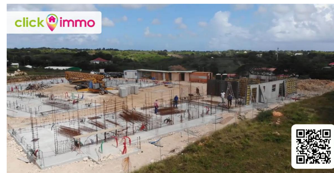
Suivi de chantier – 28 Février 2024 – Résidence les Raisiniers – Sainte-Anne
