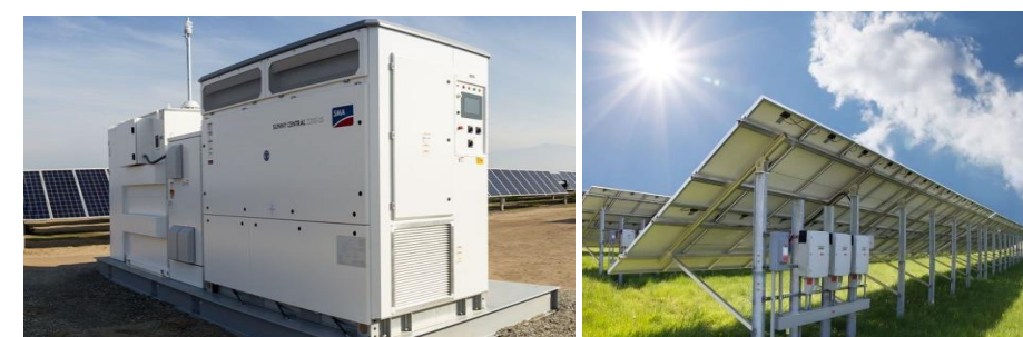
Photo 2 : Exemple d'installation d'onduleurs centralisés (à gauche) et décentralisés (à droite)
