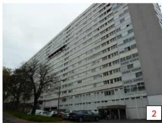
Façade Est (Côté Sud)
