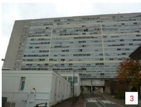
Façade Ouest (Côté Sud)
