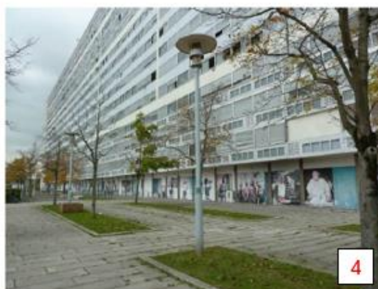
Façade Ouest (Côté Nord)
