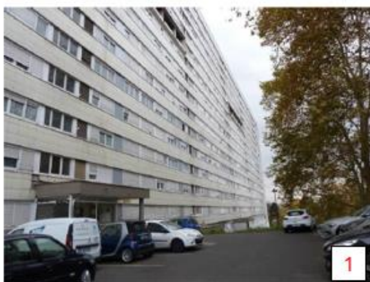
Façade Est (côté Nord)
