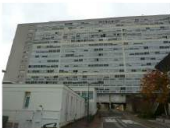
Façade Ouest (Côté Sud)
