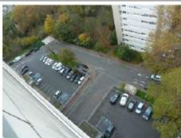
Côté Est (Parkings) – Vue du haut de la barre 110
