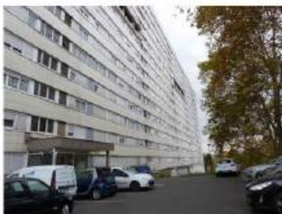
Façade Est (côté Nord)
