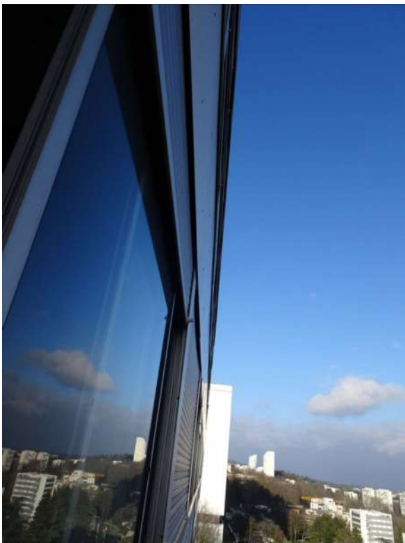
Vu des volets roulants depuis l'intérieur d'un logement...
