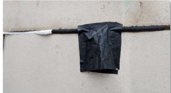
Exemple de mise en œuvre d'un SAR en « tuile » on l'on voit les obturations latérales (ici à la mousse PU puis manchon à proximité du SAR) puis la fixation du polyane à la colle mastic polypropylène
