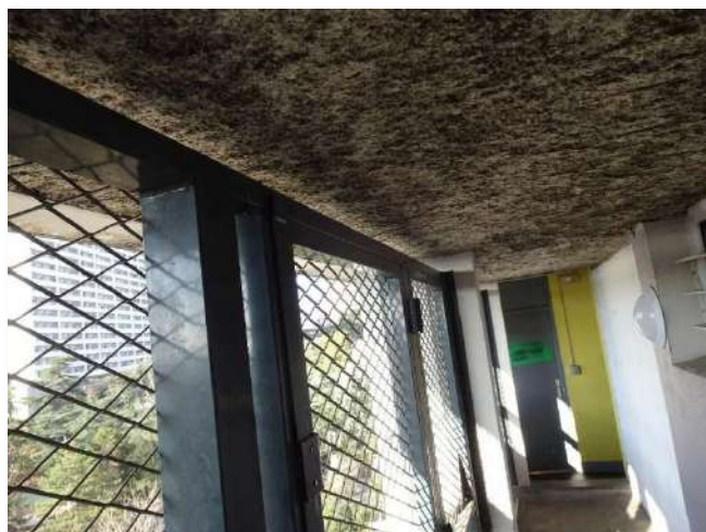
Vue d'une coursive...
