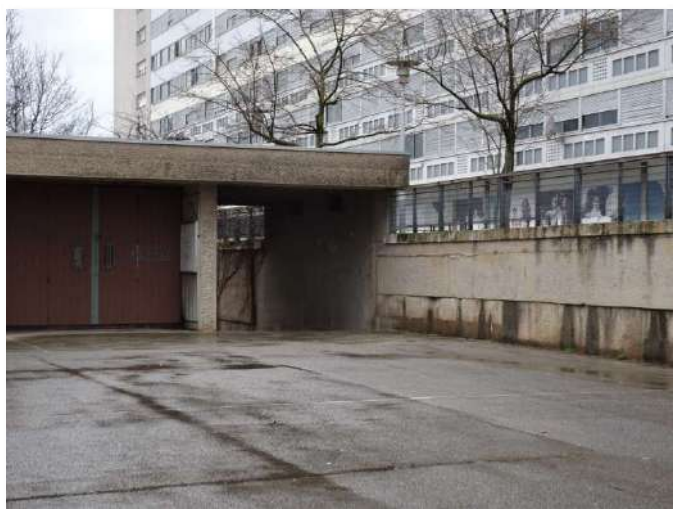
Parvis au sud de la galette commerciale, le mur de soutènement à gauche...
