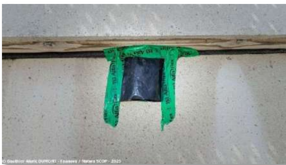
Autres exemples de SAR en « tuile » ici fixé au scotch « pare-pluie »
