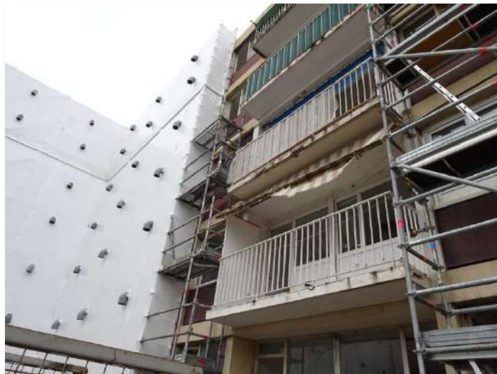
Sur la gauche de la photo, vue d'un échafaudage avec confinement par bâche thermo rétractable et coude de piquage de dépression. (Source : E. Ribatto, Natura scop, chantier sur Bron-Terraillon, novembre 2023.)
