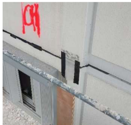
Autres exemples de SAR en « tuile » ici fixé au scotch « pare-pluie »
