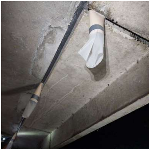
La technique du manchon PVC est particulièrement bien adaptée aux espaces avec accès vertical (ici une corniche de pont)...
