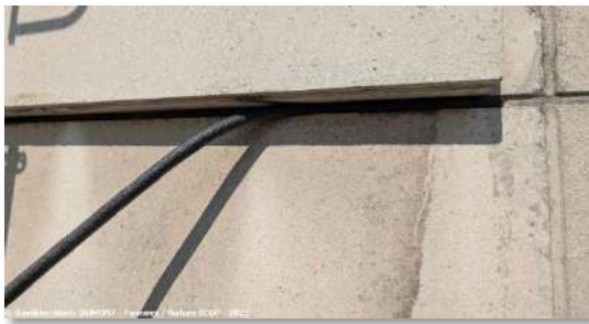
Exemple d'obturation d'habitats utilisables à l'aide de fond de joint
