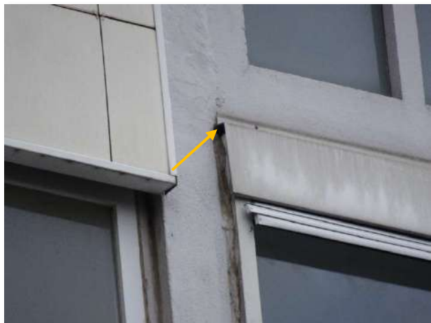
Détail d'un accès aux espaces arrière de profilé métallique...
