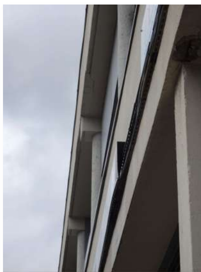
Côté est, très peu d'espaces utilisables sont présents, avec un joint de dilatation recouvert d'une baguette couvre-joint, et quasiment aucun espace au niveau des huisseries ou des encorbellements, sauf une zone disjointe (flèche orange)...
