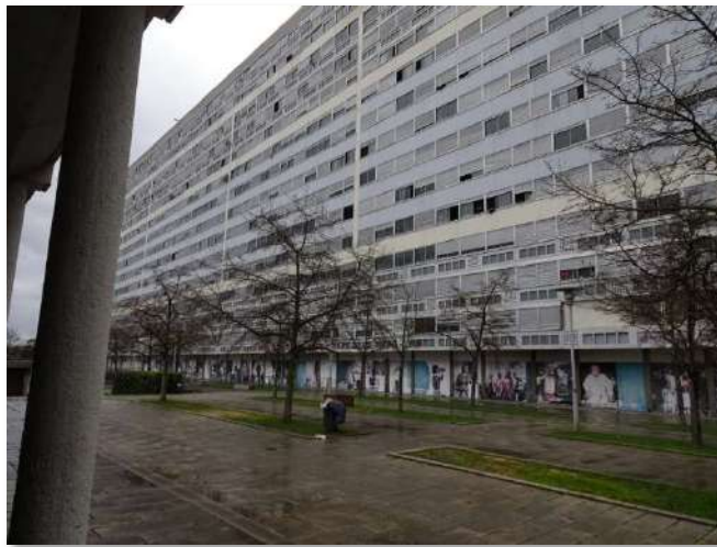
Enfin le parvis Est est occupé par des bandes enherbées étroites et quelques jeunes arbustes, ici encore sans habitats cavernicoles ou fissuricoles.
