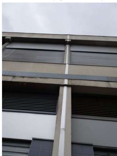
Côté est, très peu d'espaces utilisables sont présents, avec un joint de dilatation recouvert d'une baguette couvre-joint, et quasiment aucun espace au niveau des huisseries ou des encorbellements, sauf une zone disjointe (flèche orange)...
