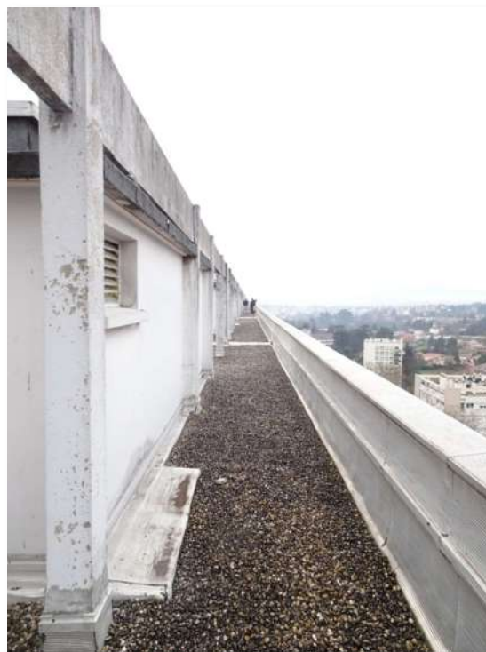
Vu de la toiture et de l'acrotère
