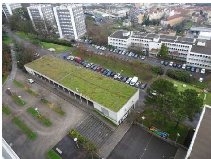
Galette commerciale et parvis coté Est depuis la toiture.
