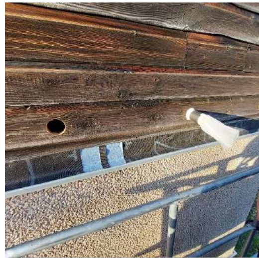
...ici le même système mis en œuvre sur des cloisonnements en bardage-bois. On note une autre technique d'obturation des accès réalisés avec du pare-vapeur agrafé au bois et collé au mastic au niveau du profilé aluminium.
