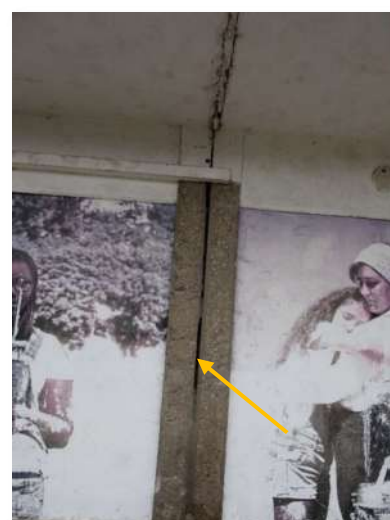
Au RDC côté parvis, on retrouve des structures en béton où l'on distingue par endroit des fentes utilisables par les chiroptères au niveau de l'encorbellement et au droit des joints de dilatation.
