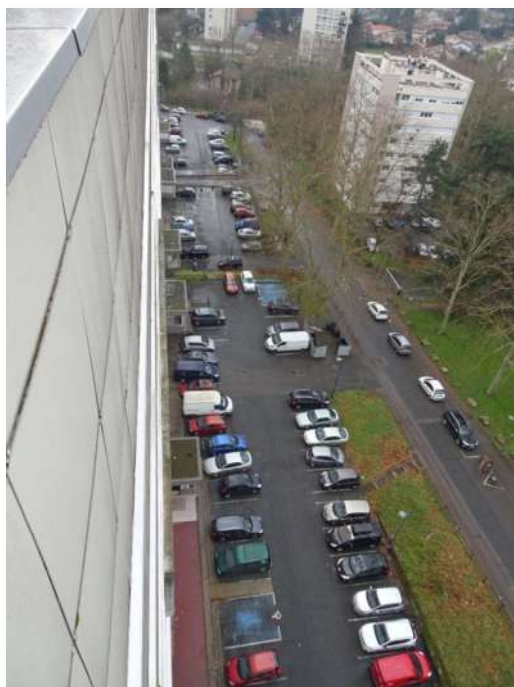
Parking et voirie depuis la toiture côté ouest.
