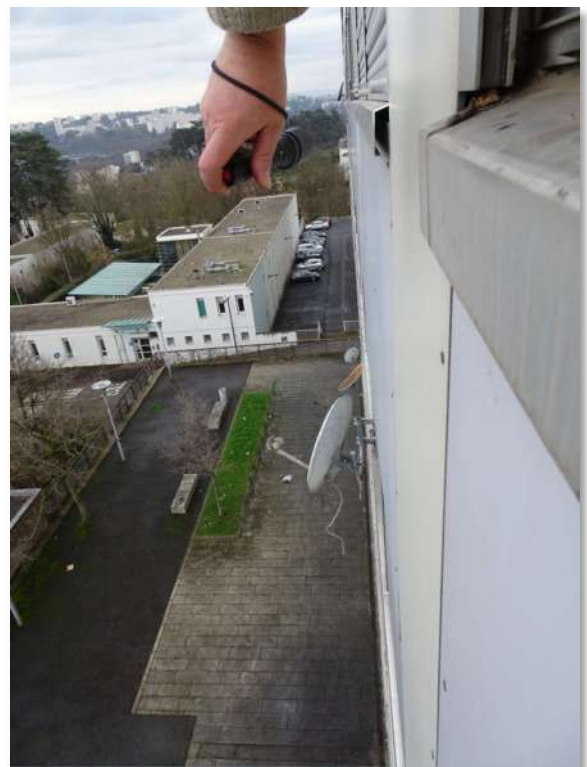
... et espace au niveau des profilés aluminium.
