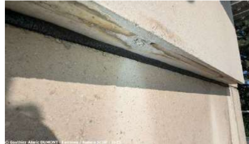
Exemple d'obturation d'habitats utilisables à l'aide de fond de joint
