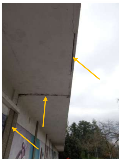
Au RDC côté parvis, on retrouve des structures en béton où l'on distingue par endroit des fentes utilisables par les chiroptères au niveau de l'encorbellement et au droit des joints de dilatation.
