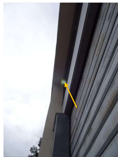
Côté est, très peu d'espaces utilisables sont présents, avec un joint de dilatation recouvert d'une baguette couvre-joint, et quasiment aucun espace au niveau des huisseries ou des encorbellements, sauf une zone disjointe (flèche orange)...
