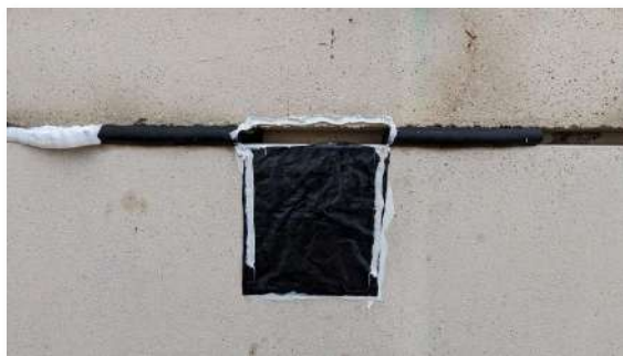
Exemple de mise en œuvre d'un SAR en « tuile » on l'on voit les obturations latérales (ici à la mousse PU puis manchon à proximité du SAR) puis la fixation du polyane à la colle mastic polypropylène
