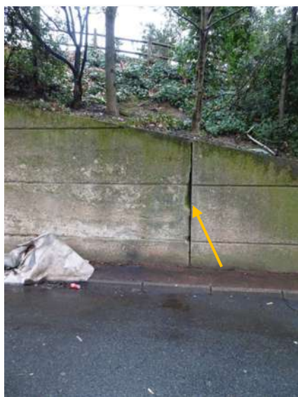
Ce type d'espace se retrouve sur le mur nord-ouest du parking...
