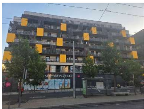
Façade du site 1791 inadapté pour réaliser des aménagements...
