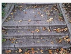
Marche en béton
