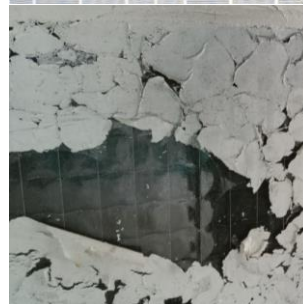
Allèges est Vue sur verre armé peint devant plaques en fibrociment
