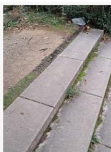
Marche en béton
