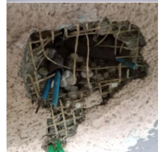
Fonds des coursives et loggias Vue sur enduit et isolant
