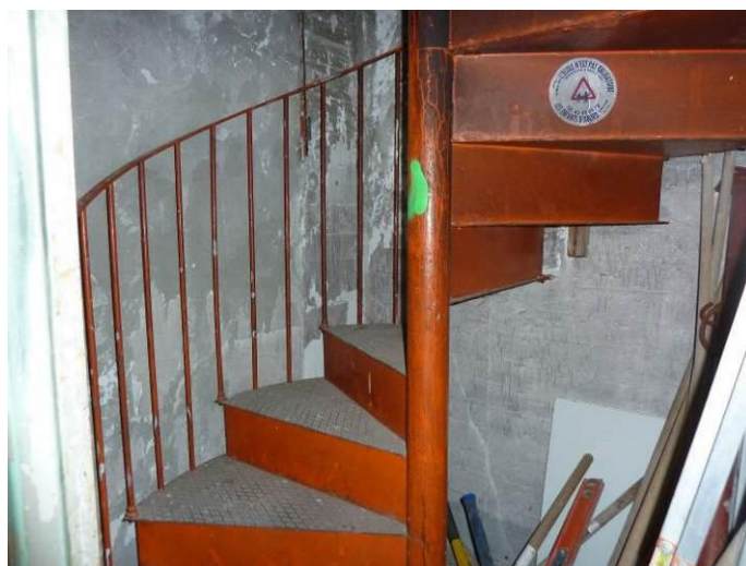
Escalier métallique d'accès aux étages
