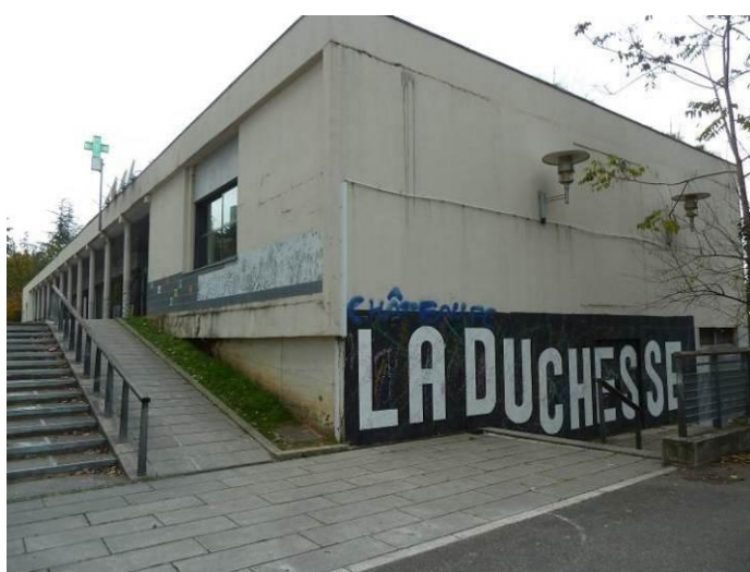
Façades Sud et Ouest
