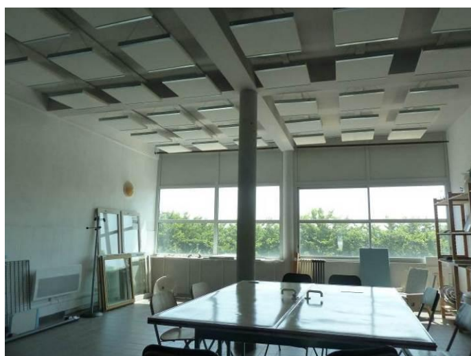
1 er étage (site occupé)
