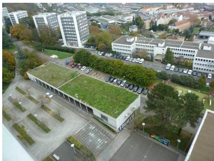
Côté Ouest (Dalle entre Barre 110 et Galette commerciale) – Vue du haut de la barre 110
