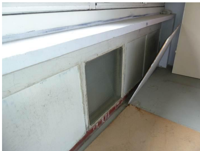
Détail allèges des balcons des loggias
