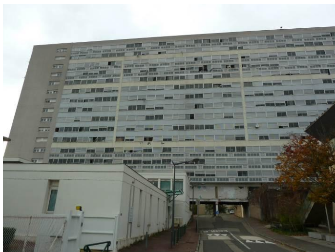
Façade Ouest (Côté Sud)
