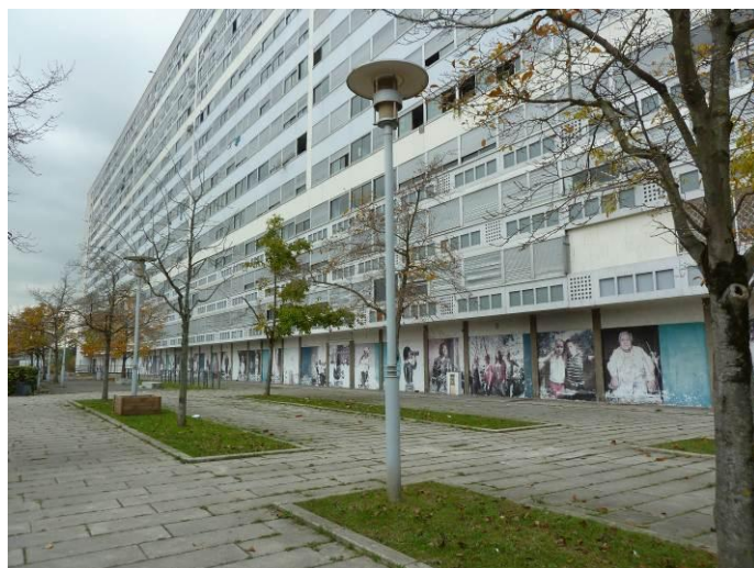
Façade Ouest (Côté Nord)
