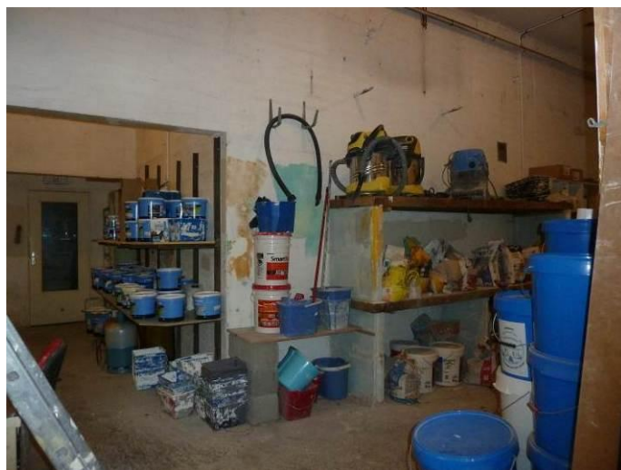
RdC Garage (site occupé)
