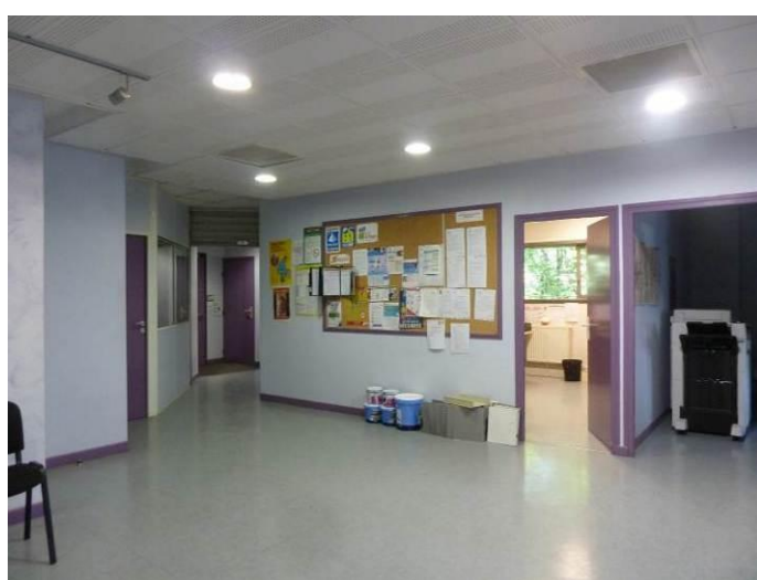
1 er étage (site occupé)
