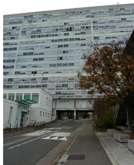
Repère B – Passage de la rue du château sous la barre 110
