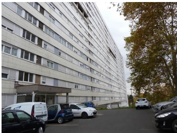
Façade Est (côté Nord)
