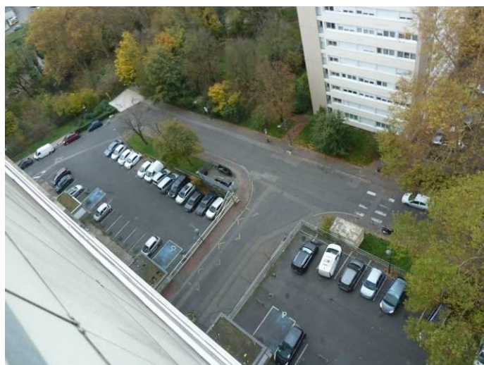
Côté Est (Parkings) – Vue du haut de la barre 110
