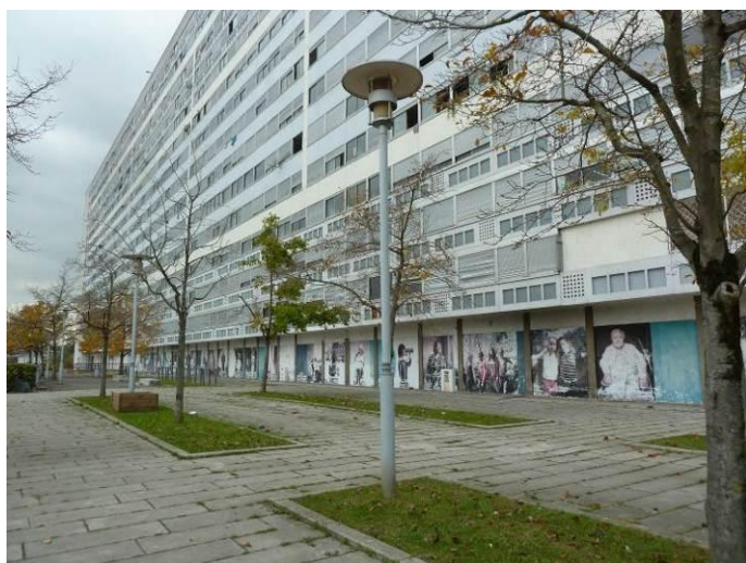
Côté Ouest (Dalle entre Barre 110 et Galette commerciale)
