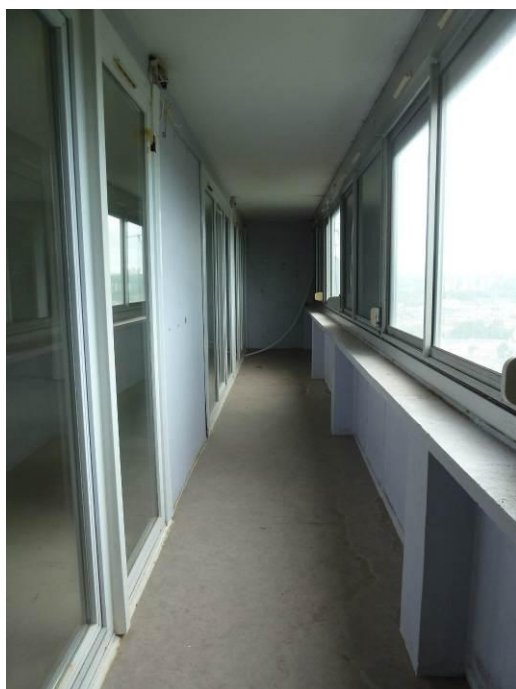
Loggia (Côté Est)
