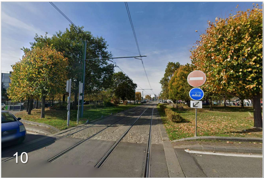
Vue sur les voies ferrées du tramway traversant le giratoire de la rue de Stalingrad à l'est
