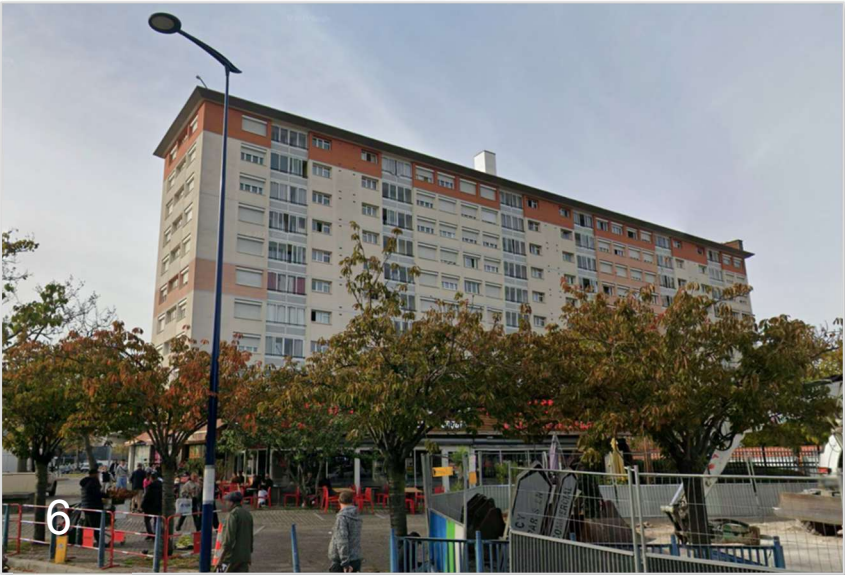
Vue sur les immeubles d'habitat collectif au nord de la rue de Stalingrad au niveau du giratoire formé par cette même rue
