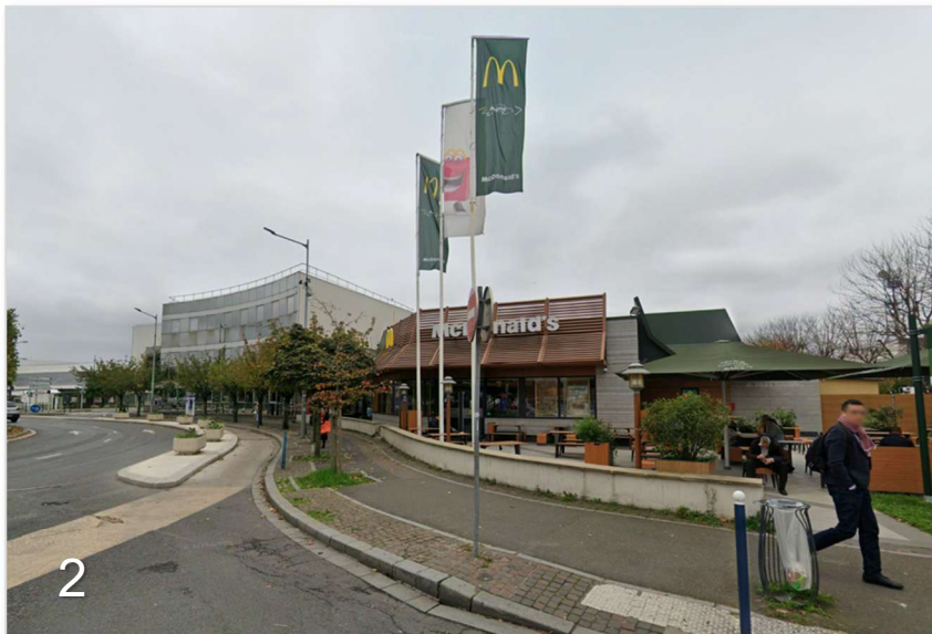
Vue sur le restaurant Mc Donald's et les locaux de la CPAM au niveau du giratoire sur la rue de Stalingrad (D986)
