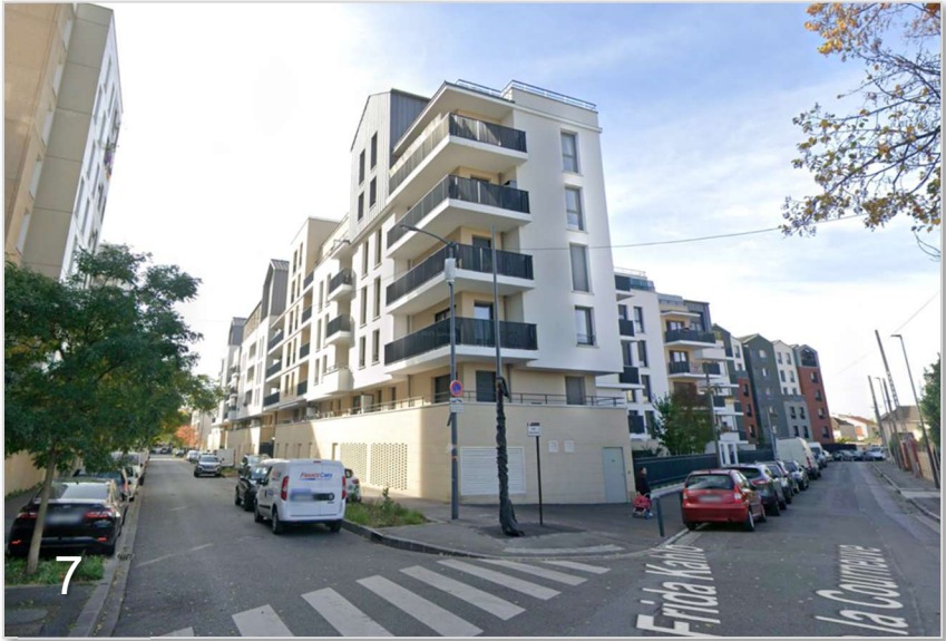
Vue sur les immeubles d'habitat collectif récents à l'angle des rues F. Kahlo et de la Courneuve au sud-ouest du site
