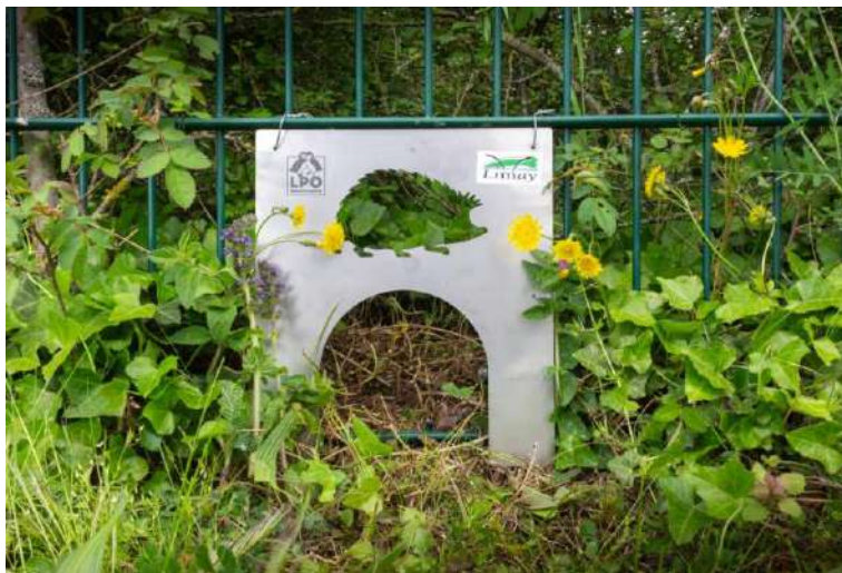
Photo 24 : Exemple de passage pour petite faune inséré dans une clôture (Source : LPO)
