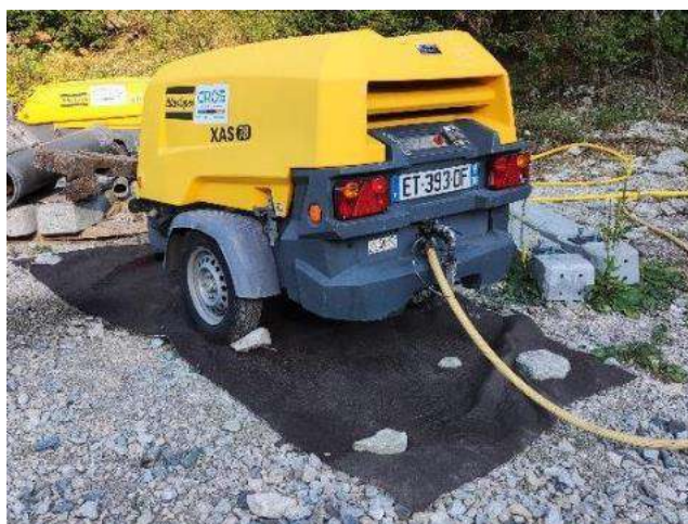
Photo 23 : Engin de chantier disposé sur un géotextile absorbant (P. SALEN, Écosphère)
