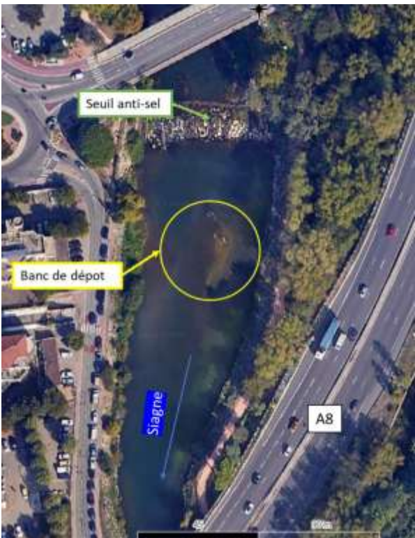
Vue aérienne du banc de dépôt en aval du seuil anti-sel (Source : SUEZ Consulting, août 2024)
