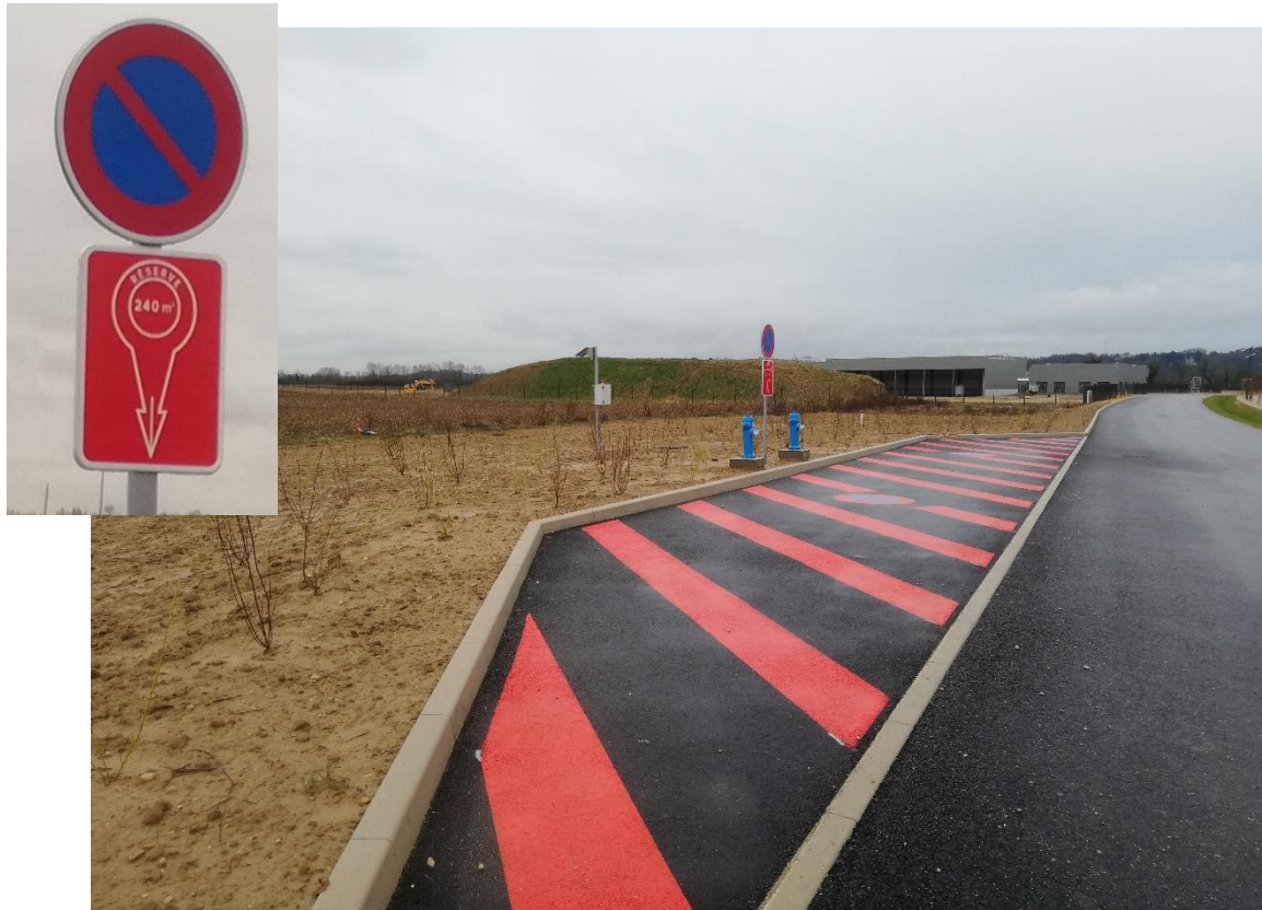
Figure 8 : Réserve incendie de 240 m 3 de la ZAC Ecosphère
