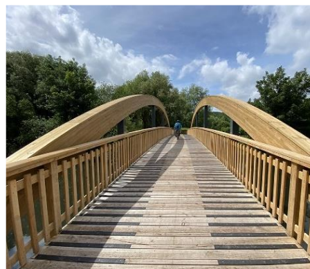
Passerelle en bois de la CC des Villes Sœurs – (Seine-Maritime et Somme)
