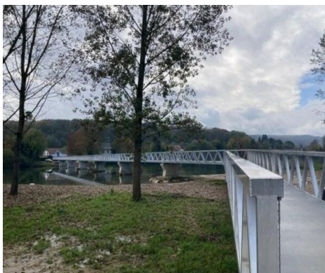
Passerelle reliant Lougres et Colombier-Fontaine (Doubs)
