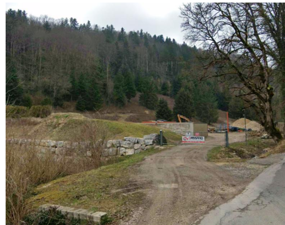
Entrée du site depuis la RD 123 à relocaliser – Sources : Google
