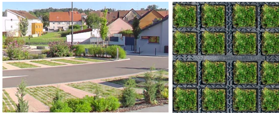
Exemple d'un parking semi-perméable à Dasle (2023) et Dalle perméable « Purple » - Source : Google et Matériaux.archi
