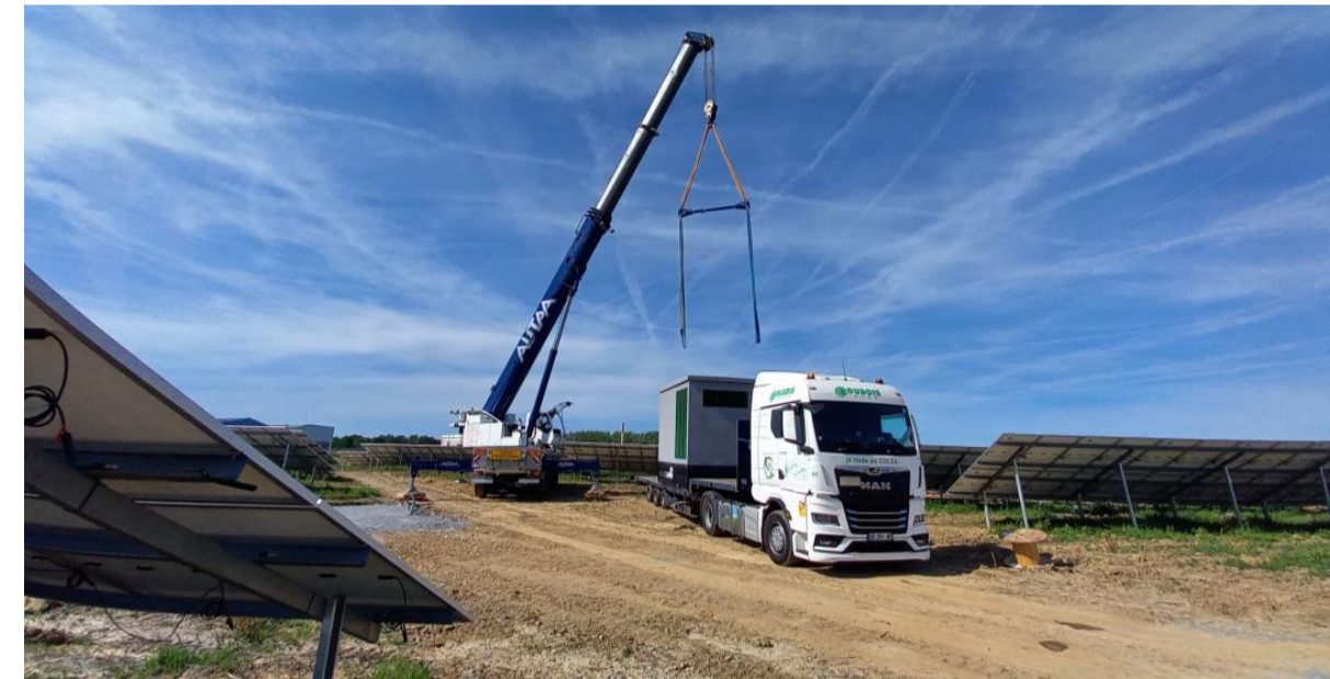
Figure 14 : Pose d'un local technique
