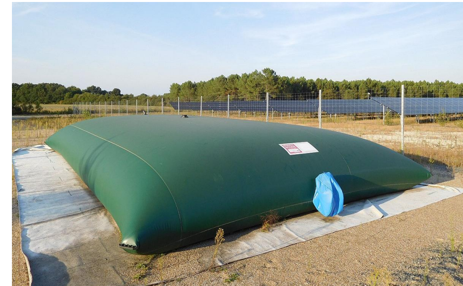
Figure 21 : Photo d'une bâche incendie
