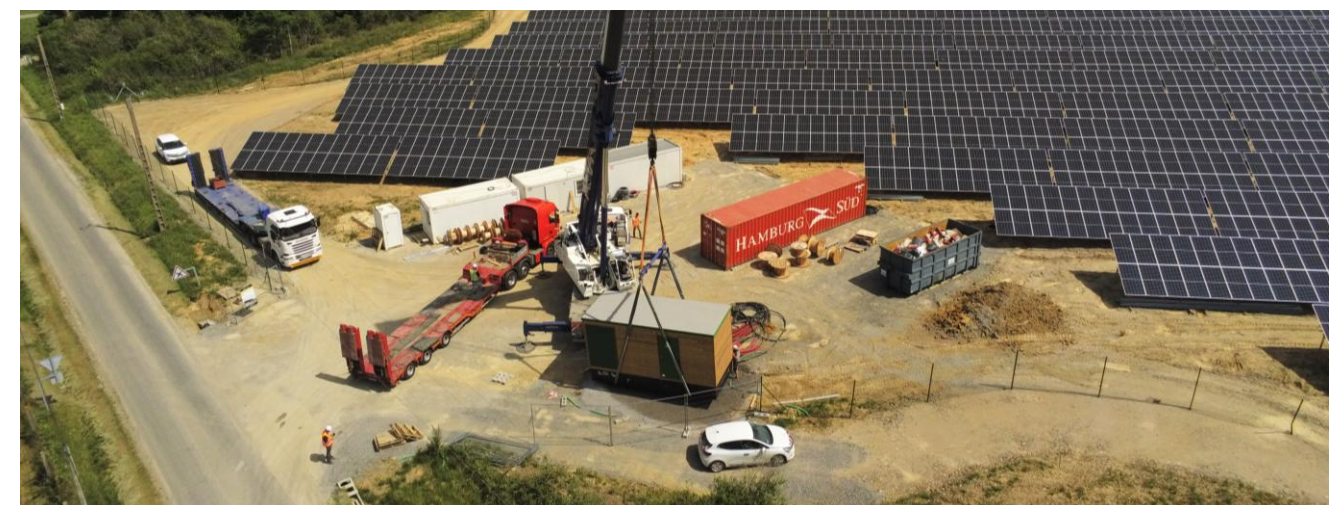
Figure 23 : Photo d'une base de vie et de stockage d'un chantier
