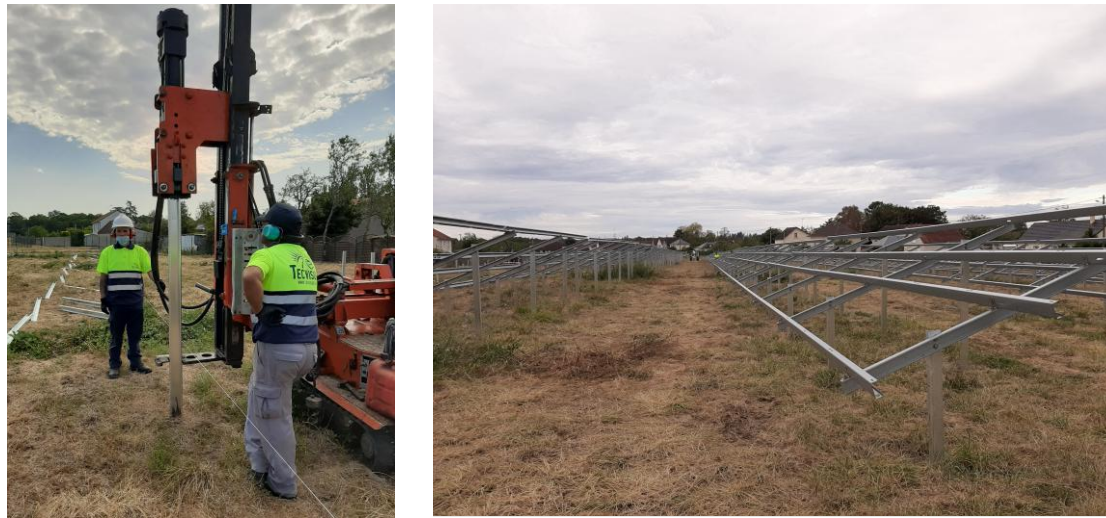
Figure 24 : Montage des modules
