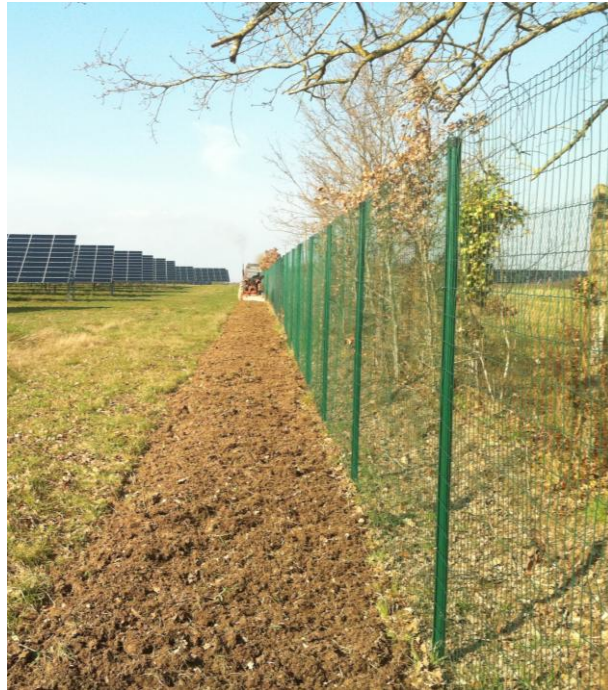
Figure 19 : Photo d'une clôture
