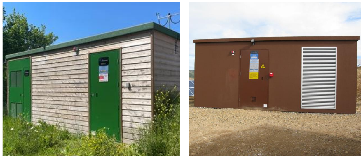
Figure 13 : Exemple de poste de livraison et poste de transformation
