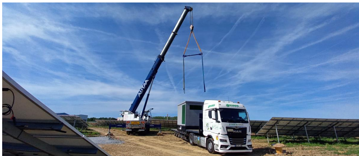
Figure 25 : Installation d'un local technique
