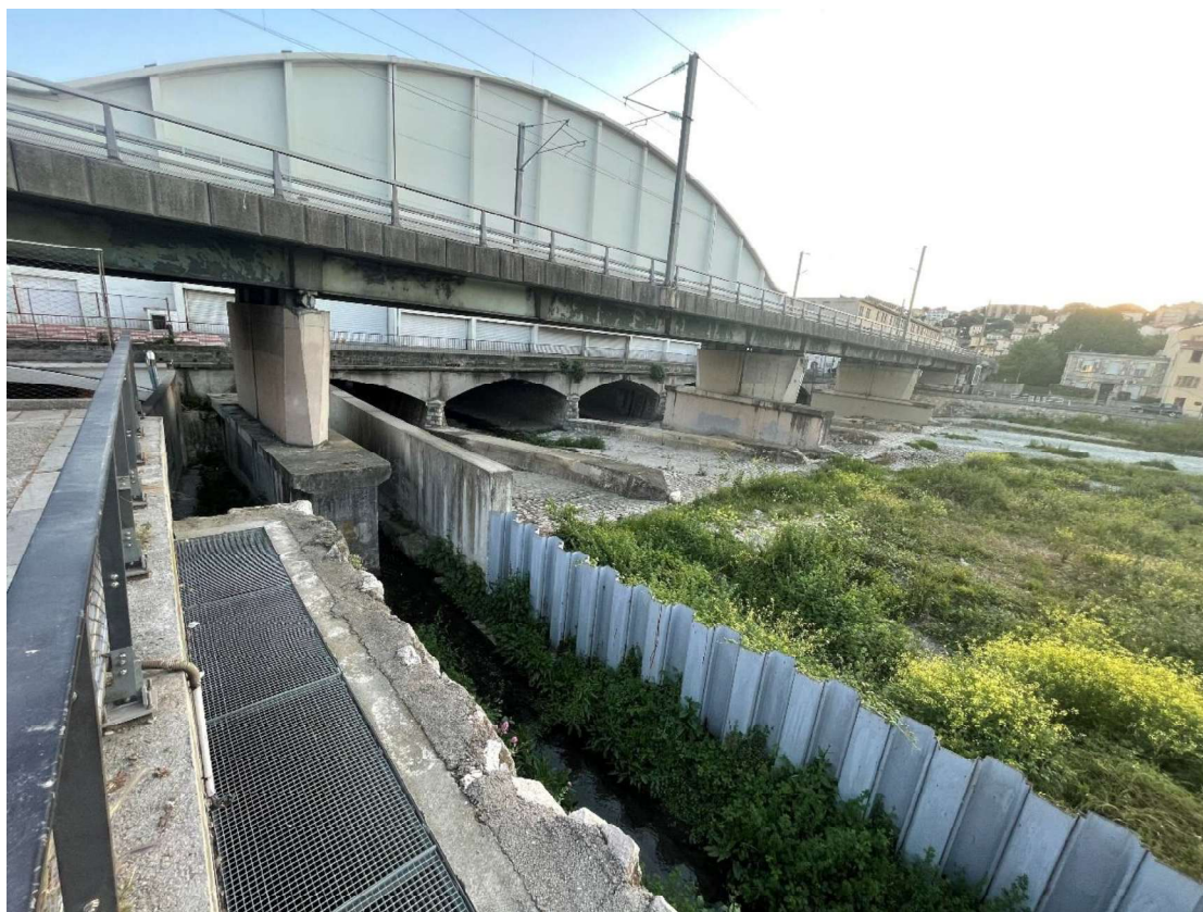
Figure 6 : photo aérienne de 04/2026 correspondant à la prise numéro 6 sur le plan de situation : Zone de rejet du siphon Vérany en amont de la grande couverture
