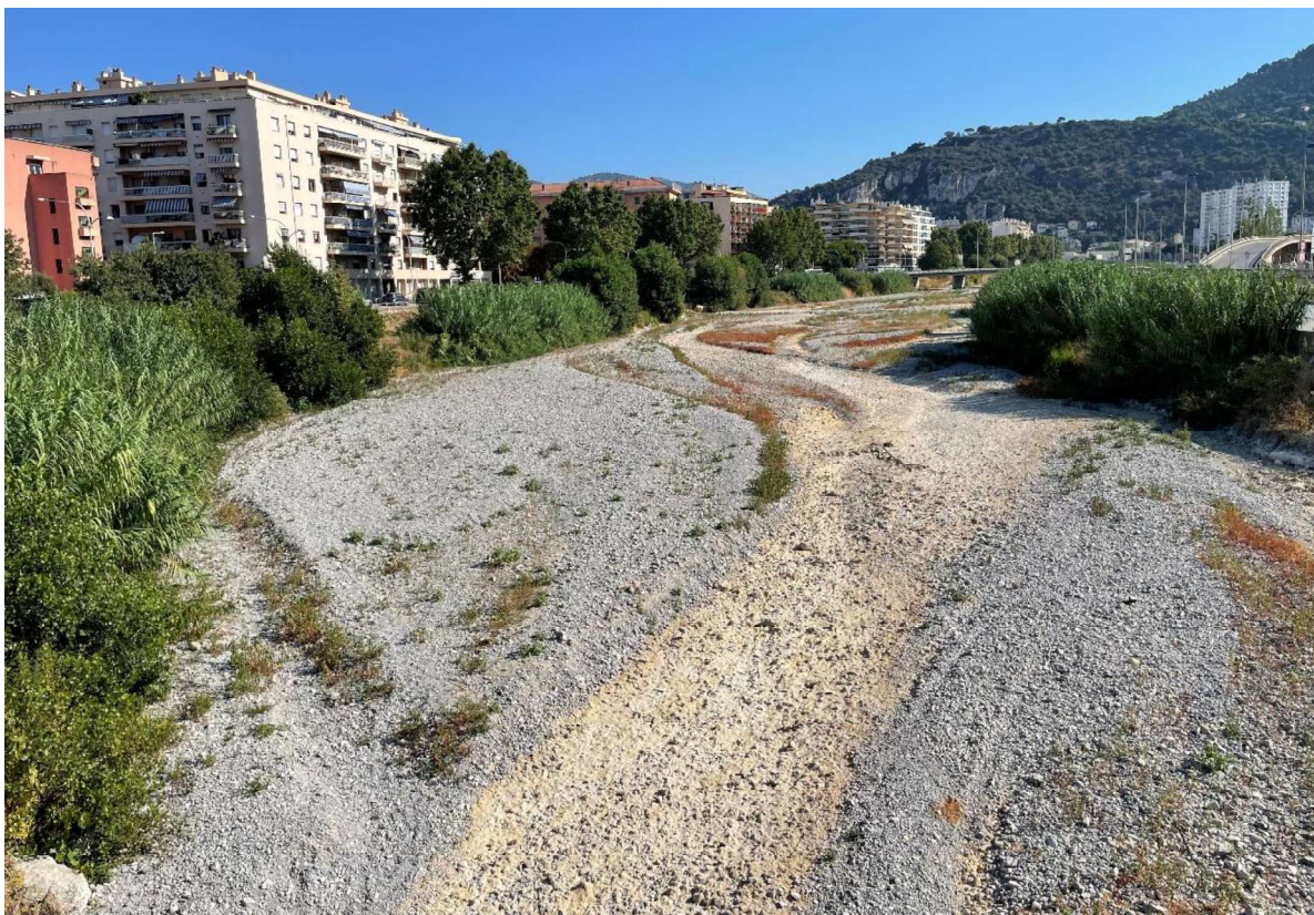
Figure 2 : photo aérienne de 08/2024 correspondant à la prise numéro 2 sur le plan de situation : linéaire entre le Pont des abattoirs et l'amont de la petite couverture
