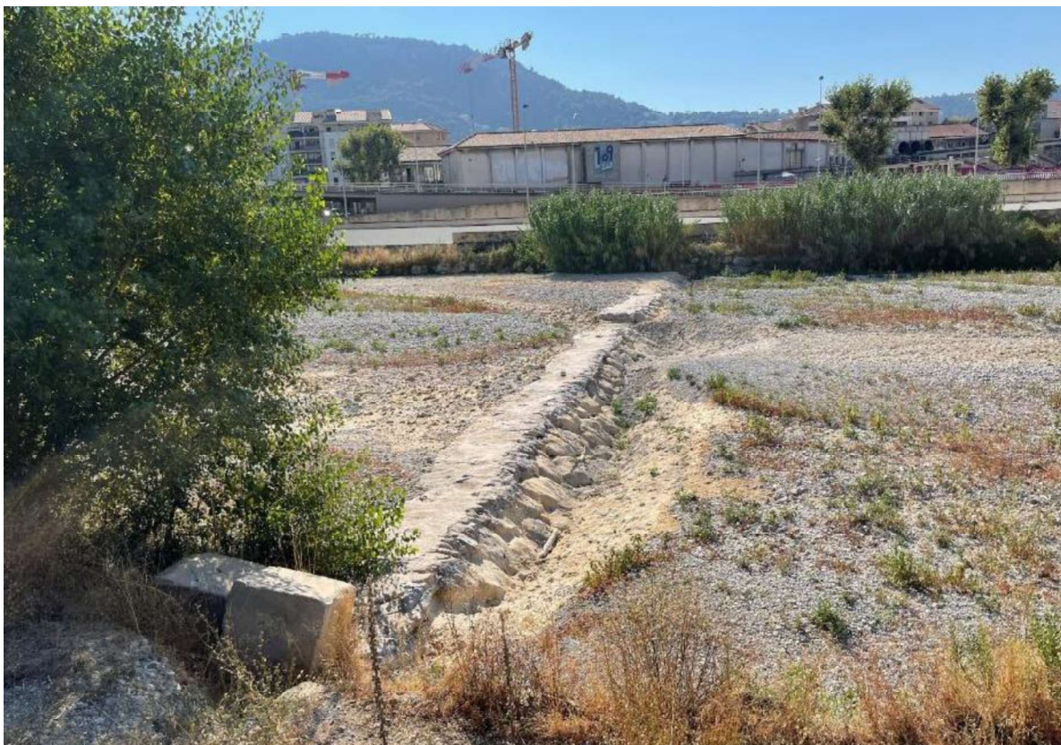
Figure 1 : photo aérienne de 08/2024 correspondant à la prise numéro 1 sur le plan de situation : Seuil 2
