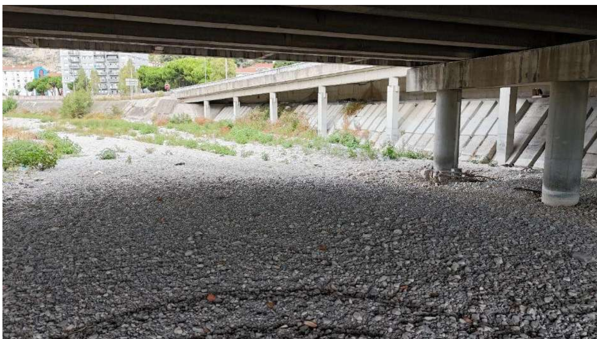
Figure 6 : photo aérienne du 01/10/2025 correspondant à la prise numéro 6 sur le plan de situation : Vue sous le Pont René Coty
