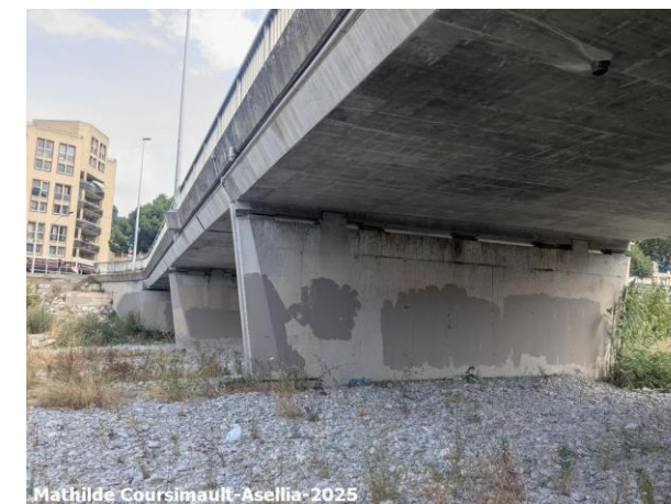
Pont des Abattoirs (enjeu modéré) abritant des gîtes utilisables (corniches)
