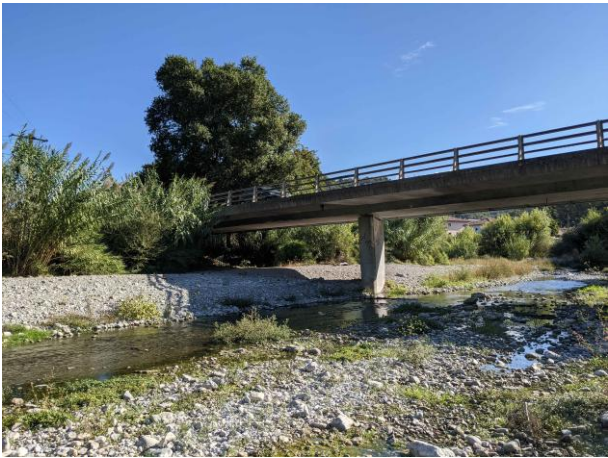
Ripisylve discontinue et dégradée à mesure que le paillon pénètre dans l'aire urbaine
