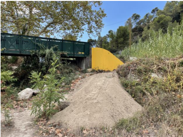
Aperçu de la rampe confortée en septembre 2023 et peinture du mur de soutènement
