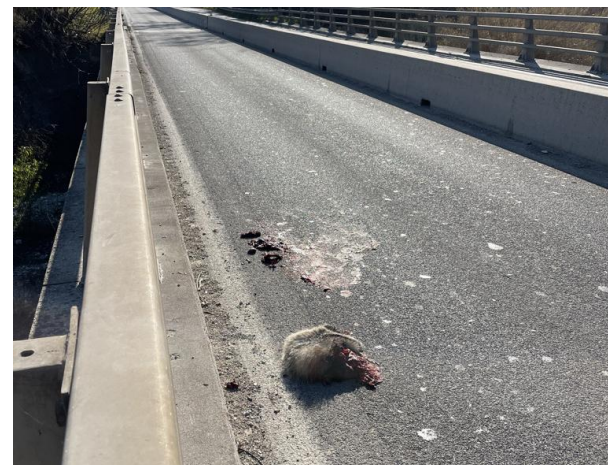
Blaireau écrasé au niveau du pont de la pénétrante en amont de la STEP de Drap en février 2023 – Photo J. CUVELIER
