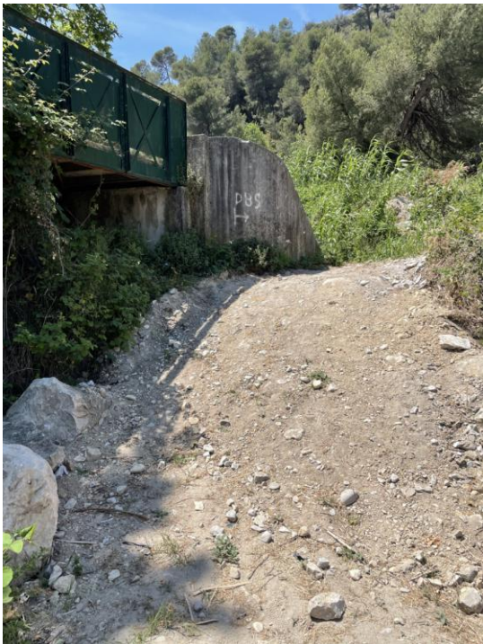
Création de la rampe avec du remblais et des matériaux terreux exogènes en mai 2022
