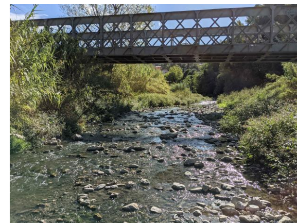
Pont en structure d'acier sans gîte utilisable, défavorable pour les Chiroptères
