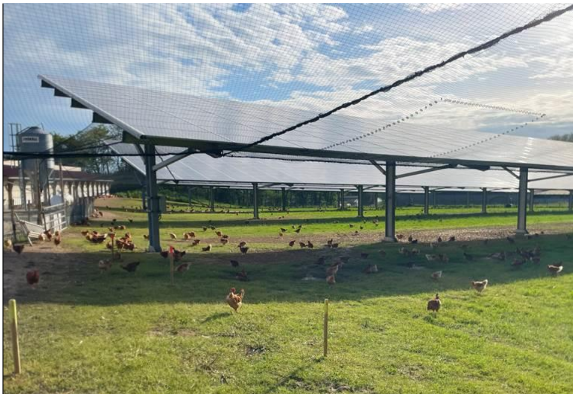
Figure 17 : Photographie d'une volière photovoltaïque Technique Solaire (47) dans le cas d'un élevage de poulets de chair, avec à gauche le bâtiment d'élevage relié directement aux panneaux solaires et à la clôture périphérique, formant un clos total.
