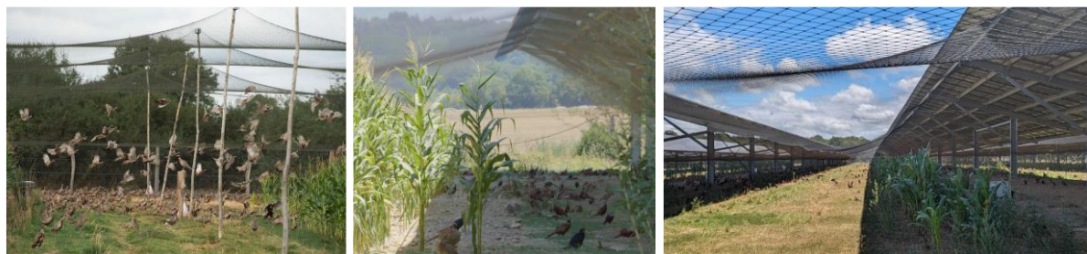
Figure 2 : Illustration de volières traditionnelles fragiles avec filets & poteaux bois ET volières photovoltaïques Technique Solaire
