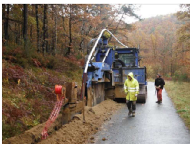
Figure 27 : Pose de câble à la trancheuse
