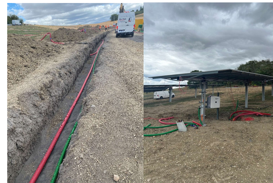
Figure 26 : Illustration de tranchées de câbles (source : TSE)
