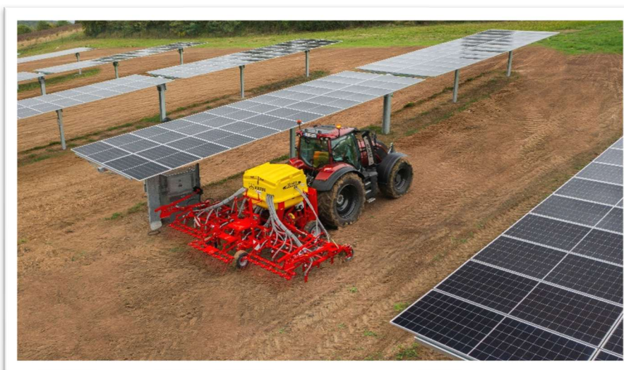
Figure 13 : Ombrière de culture construite dans le Puy-de-Dôme (source : TSE)
