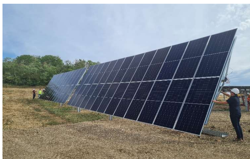
Figure 17 : Installation des panneaux (source : TSE)
