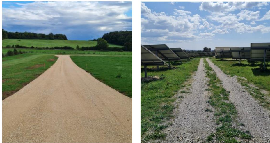
Figure 48 : Exemple de piste d'exploitation en grave concassée (source : TSE Energy)
