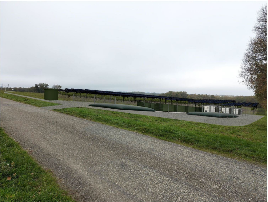
Etat final du site avant aménagement paysager
