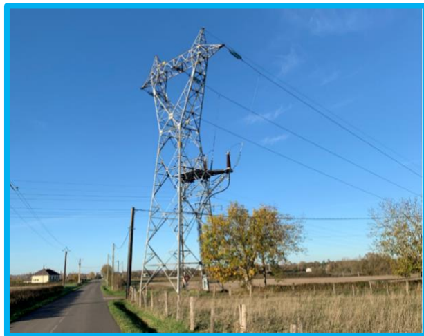
Figure 42 : Exemple d'adaptation aérosouterraine sur pylônes
