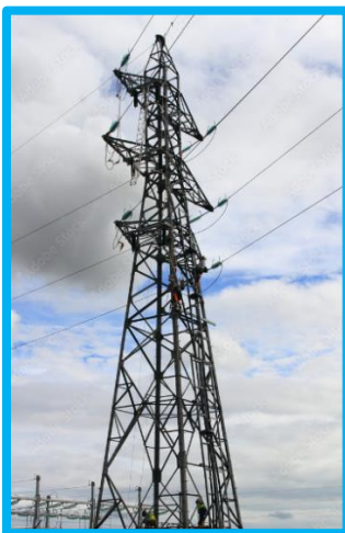
Figure 42 : Exemple d'adaptation aérosouterraine sur pylônes
