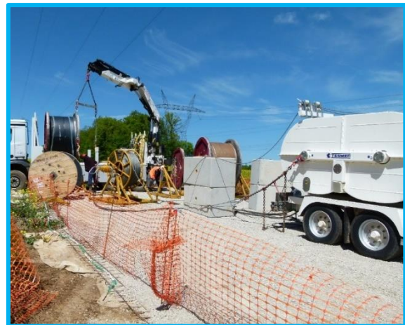
Figure 32 : Plateforme de déroulage
