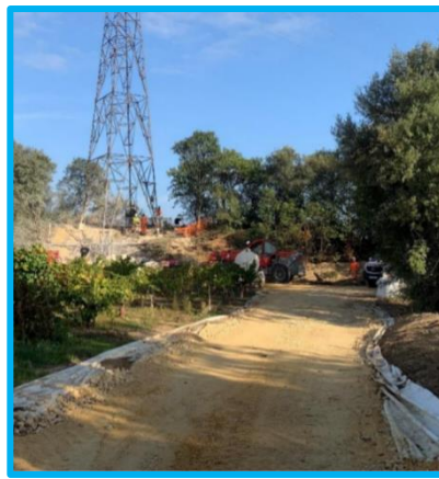
Figure 101 : Exemple de piste provisoire en concassé
