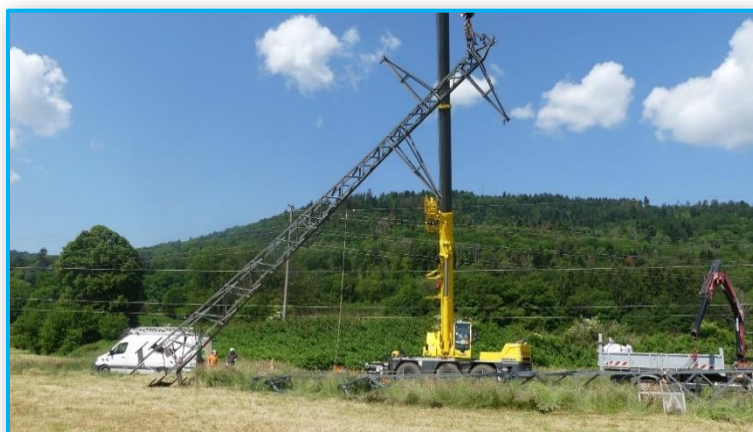
Figure 43 : Dépose de pylône à la grue
