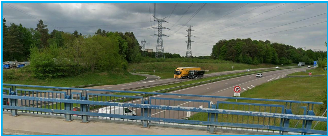
Figure 73 : Vue sur une ouverture du couloir depuis un ouvrage d'art de la R.D.72 enjambant l'A4 (6)
