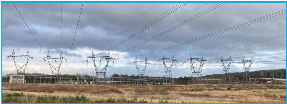
Figure 21 : Type de pylônes utilisés « à fenêtre »
