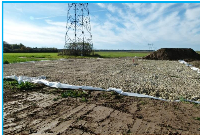
Figure 27 : Plateforme d'assemblage et de levage
