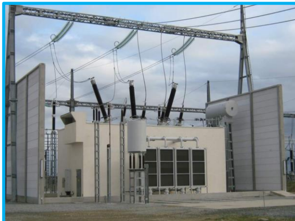
Figure 5 : Autotransformateur 400 000/ 225 000 volts
