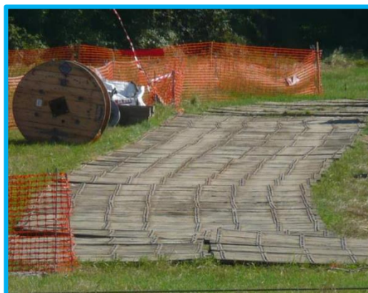
Figure 102 : Exemple de piste provisoire en plaques
