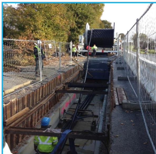
Figure 41 : Déroulage des câbles
