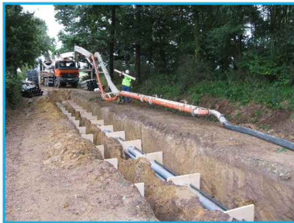
Figure 39 : Pose en fourreaux PVC bétonnés
