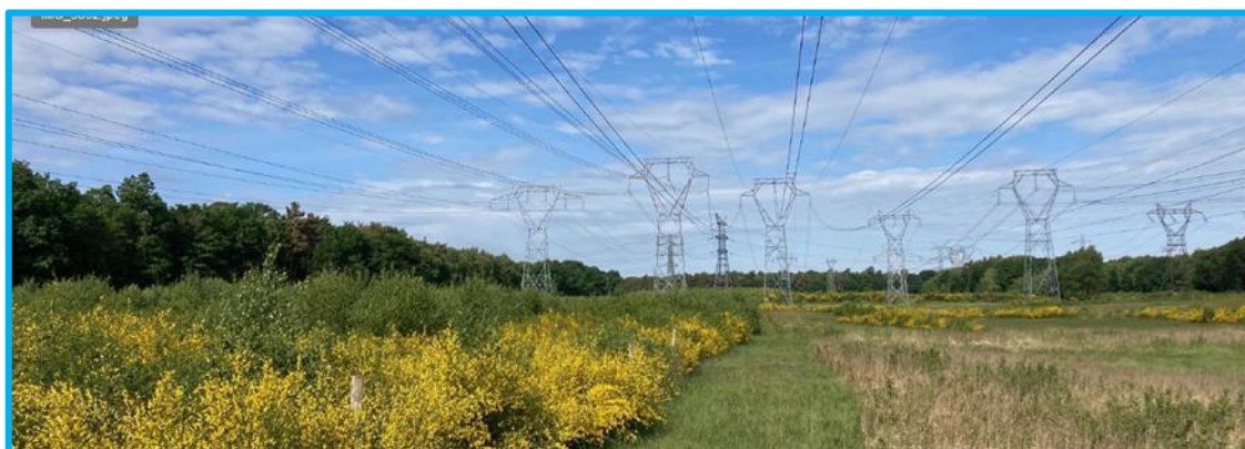
Figure 13 : Couloir de lignes électriques à l'ouest du poste électrique de SAINT-AVOLD
