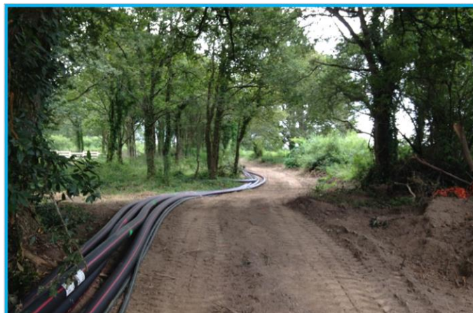
Figure 38 : Contexte de chantier de liaisons souterraines
