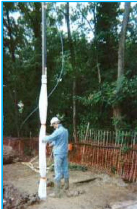
Figure 30 : Coulage du béton des pieux
