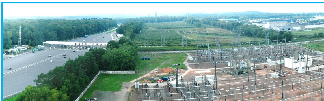
Figure 12 : Couloir de lignes électriques à l'ouest du poste électrique de SAINT-AVOLD entre l'A4 et l'Europart
