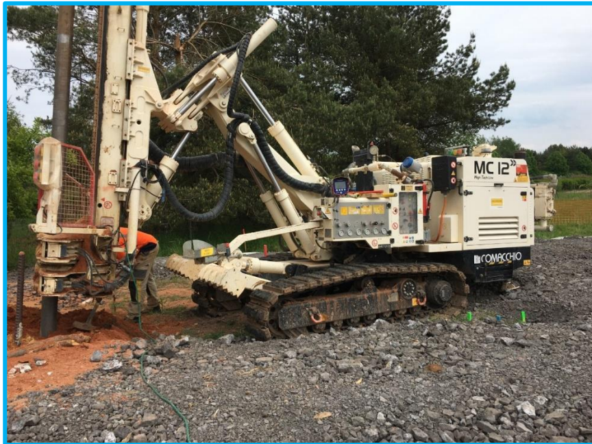
Figure 29 : Exemple de machine à forer les pieux sur chenilles
