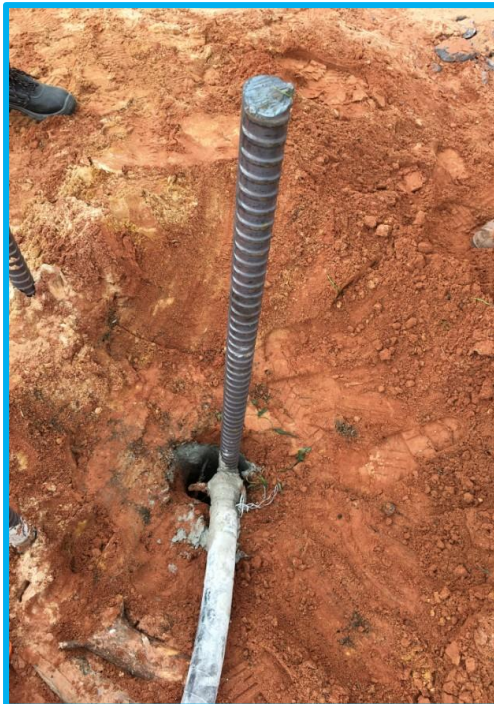
Figure 30 : Coulage du béton des pieux
