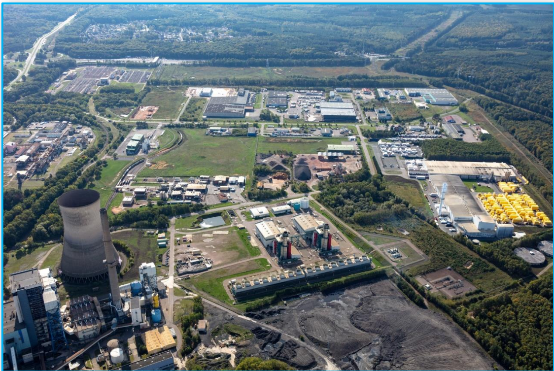
Figure 66 : Vue aérienne d'ensemble du site et de ses abords (①)
