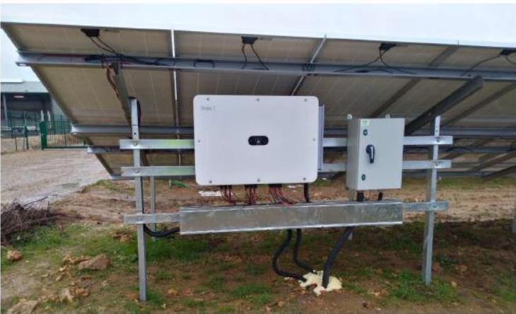
Figure 9 : Exemple d'installation d'un onduleur sur une structure porteuse Source : EES
