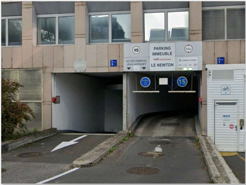
Accès / sortie du parking de l'immeuble Le Newton (vue depuis la rue de Strasbourg)
