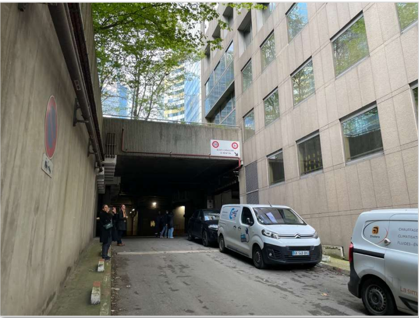
Voie de service mutualisée (vue en direction des infrastructures des immeubles desservis)
