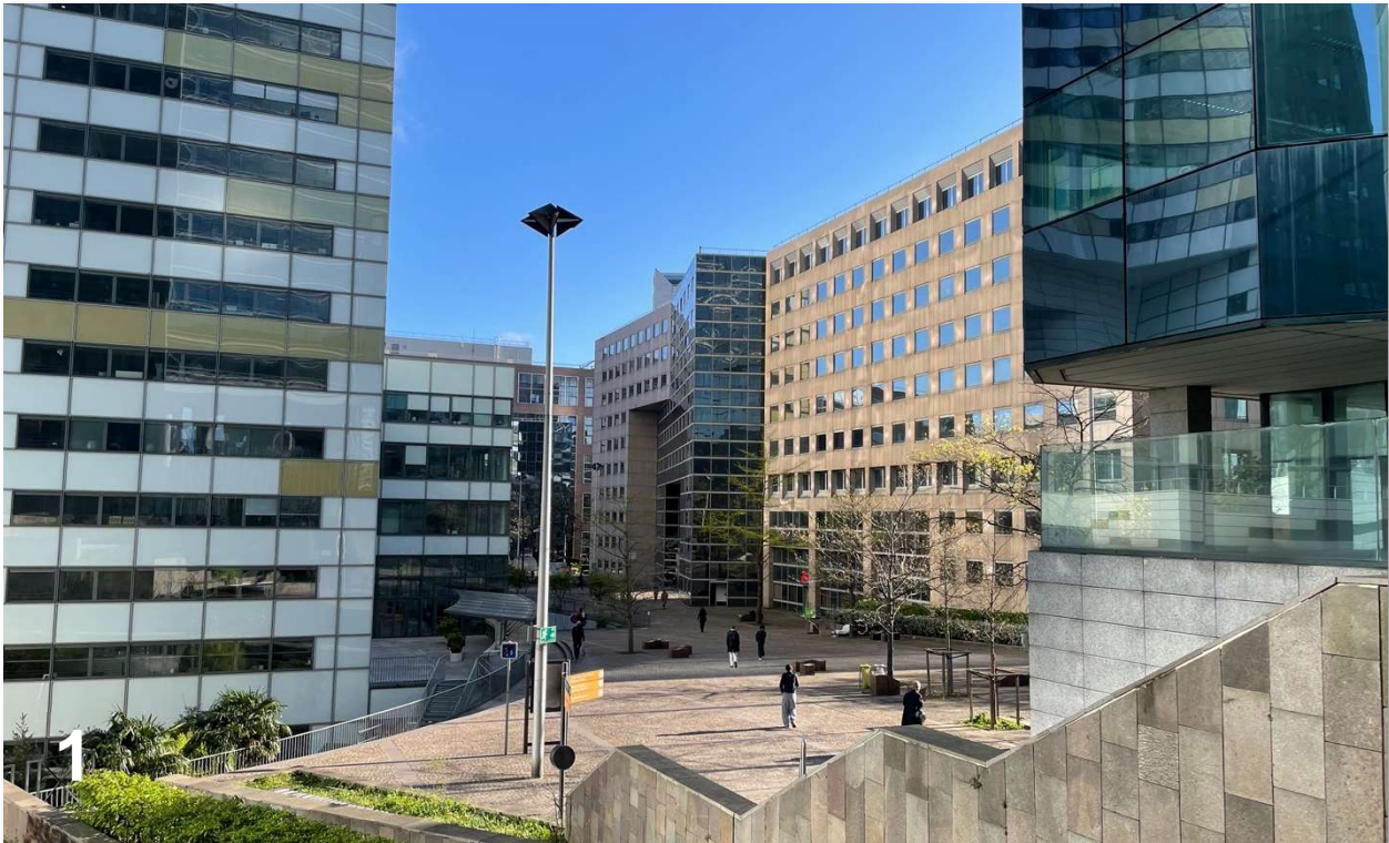
Vue en direction du site depuis les abords de la tour Monge à environ 80 m du site, au sud-ouest
