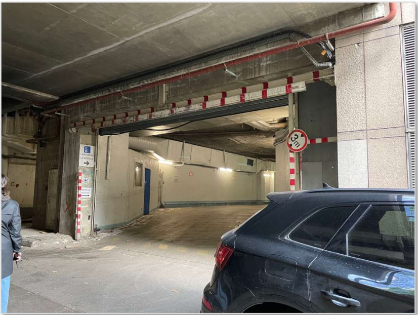
Accès à l'aire de livraison et d'enlèvement des déchets de l'immeuble Le Newton
