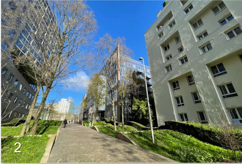
Vue sur l'immeuble de bureaux Lavoisier et un immeuble de logements collectifs au nord du site
