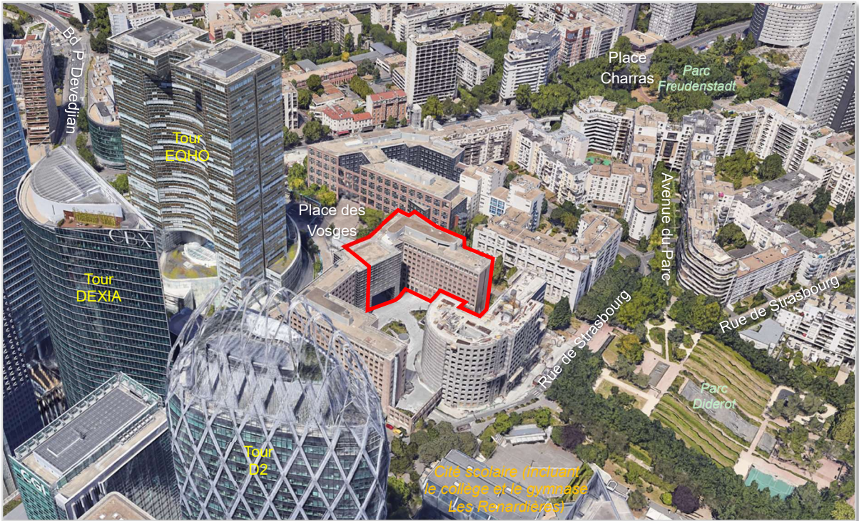
Vue en direction du nord
