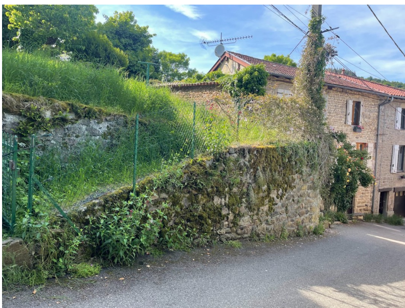
Figure 3: Mur de soutènement de l'OAP n°5 (Source : MRAe)
