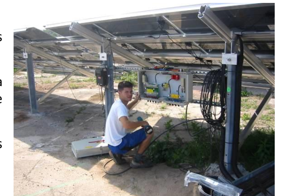
Raccordement de câbles solaires en coffret électrique
