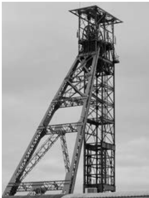
Figure 67 : Photographie du chevalement du puits n°1 bis
