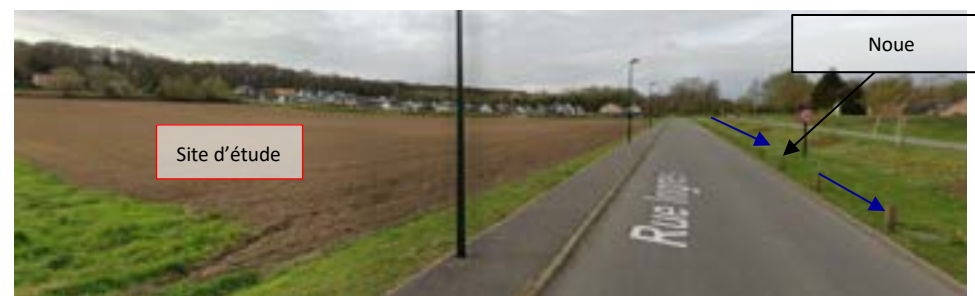
Figure 8 : Noue de la rue d'Ingres
