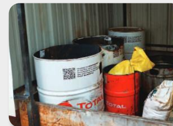
Aire de stockage des matériaux polluants dans un container (source : Eiffage) et Protection des dépôts provisoires à l'aide de géomembranes (source : Biotope)
