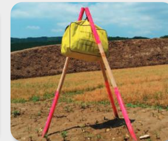
Mise en place d'un géotextile absorbant (source : Biotope) et Kit antipollution isolé du sol (source : Eiffage)
