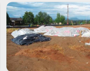
Aire de stockage des matériaux polluants dans un container (source : Eiffage) et Protection des dépôts provisoires à l'aide de géomembranes (source : Biotope)
