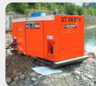
Mise en place d'un géotextile absorbant (source : Biotope) et Kit antipollution isolé du sol (source : Eiffage)
