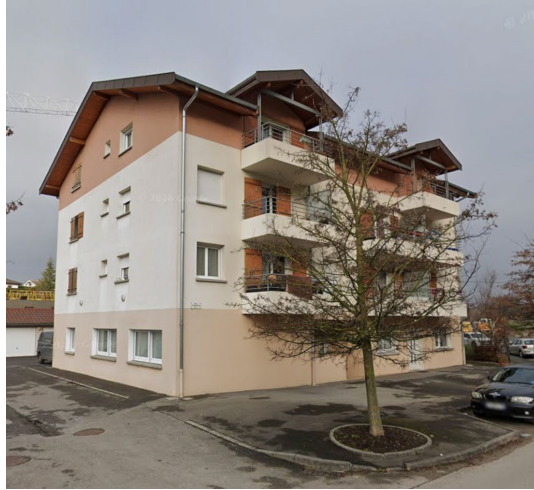
Bâtiment possédant un rez-de-chaussée commercial actuellement identifié au PLU (professions de santé et paramédical) photo Google streetview novembre 2023
