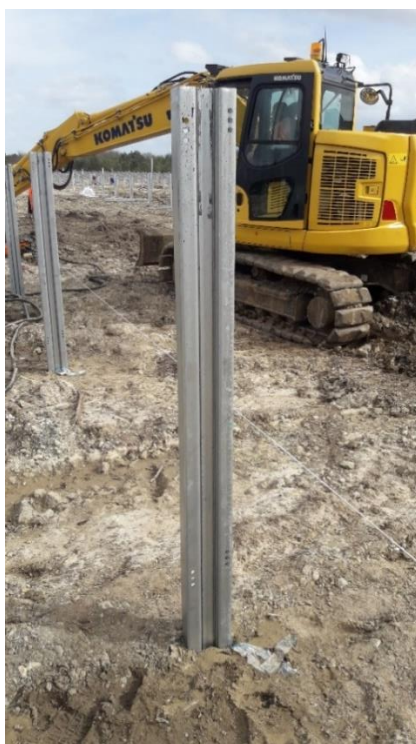
Figure 16: Exemple de pieux de type profilé métallique battu dans le sol (source : Antea Group)
