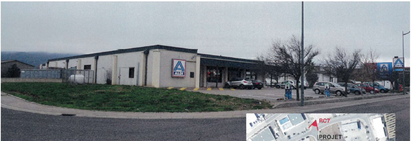
Photo 1 : Etat des lieux – magasin existant
