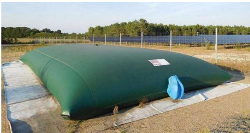
Illustration 3 - Exemple de citerne souple autoportante d'eau de défense incendie
