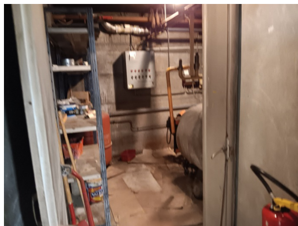
Vue Zone 1 - RDC
