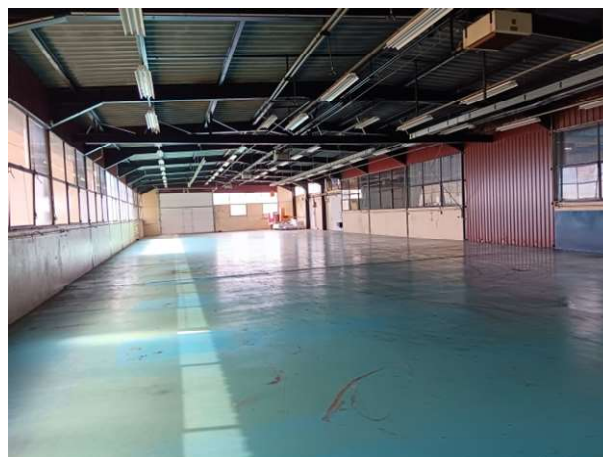
Vue Zone 2 - RDC
