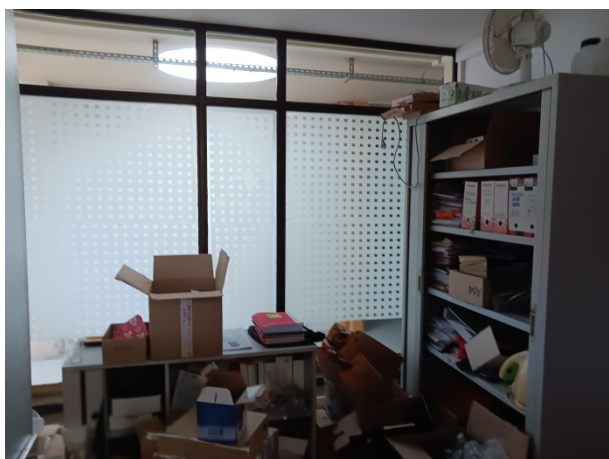
Vue Zone 1 - RDC
