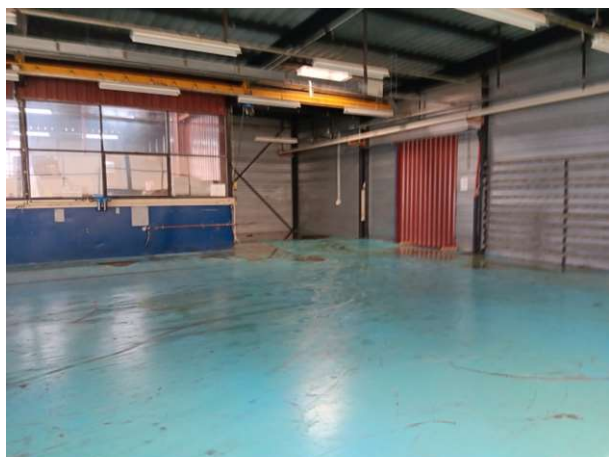
Vue Zone 2 - RDC
