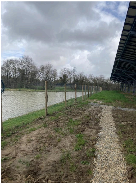
Photos : Tranchées drainantes
