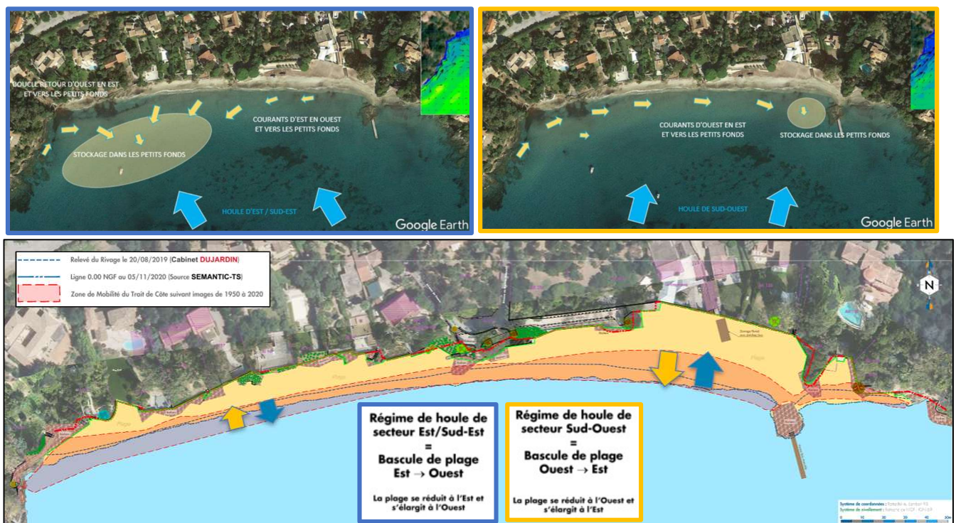
Figure 2 : Régimes pilotant la bascule du trait de côte et zone de mobilité du trait de côte observée sur les images aériennes entre 1950 et 2020 (étude de faisabilité 2020-2021)
