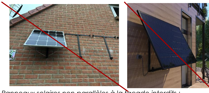
Panneaux solaires non parallèles à la façade interdits :
