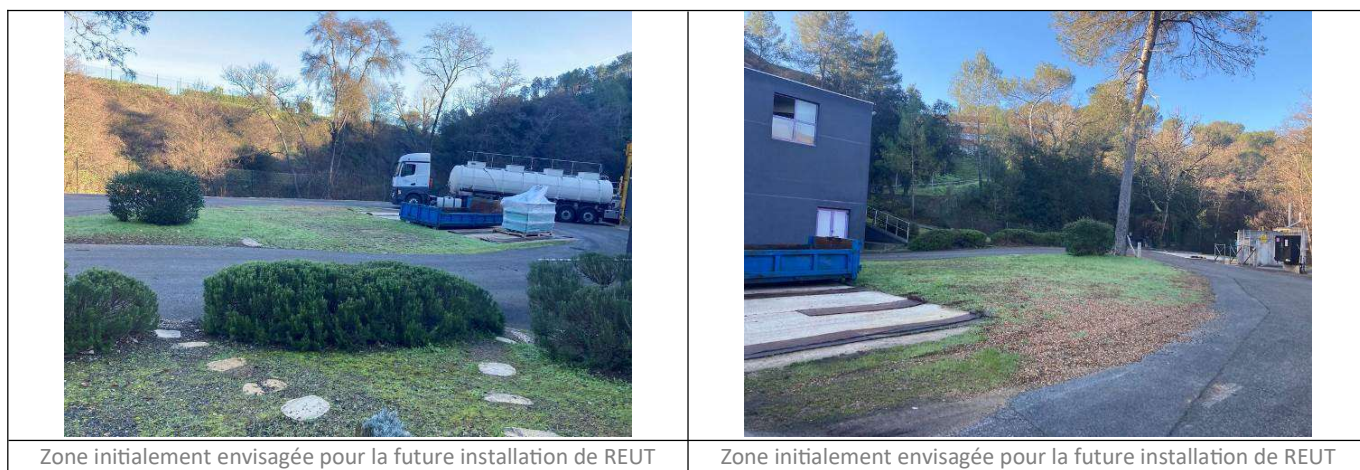
Fig.25 - Vues de la station
