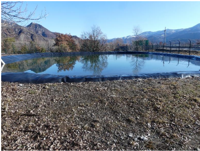
Bassin artificiel en eau sur le site d'étude Sylvain Fouque (ARTIFEX), 26-01-2026
