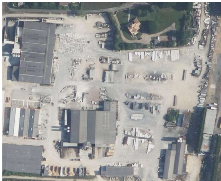
Vue satellite des produits bétons finalisés stockés à l'air libre
