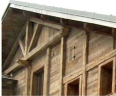
EXEMPLE DE BARDAGE avec bois de recoupement et pose de bardage horizontal et vertical
